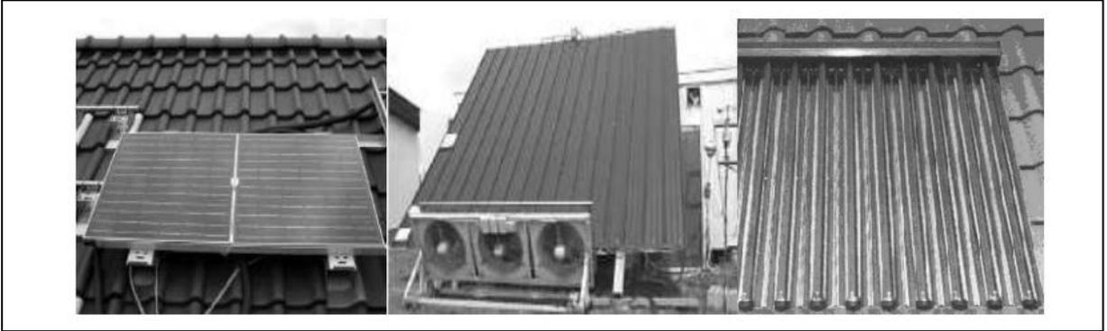
**Figure II.16 : Exemple de capteurs solaires plans, non vitrés et de capteurs solaires à tube sous-vide**
