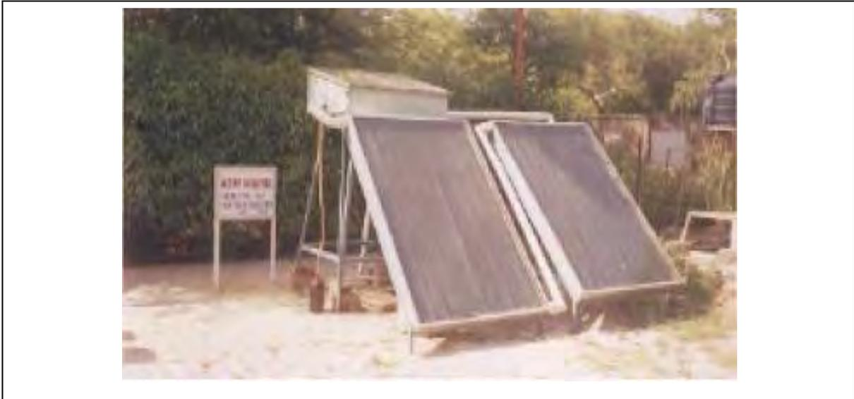
Figure II.10 : Système de distillation solaire actif
