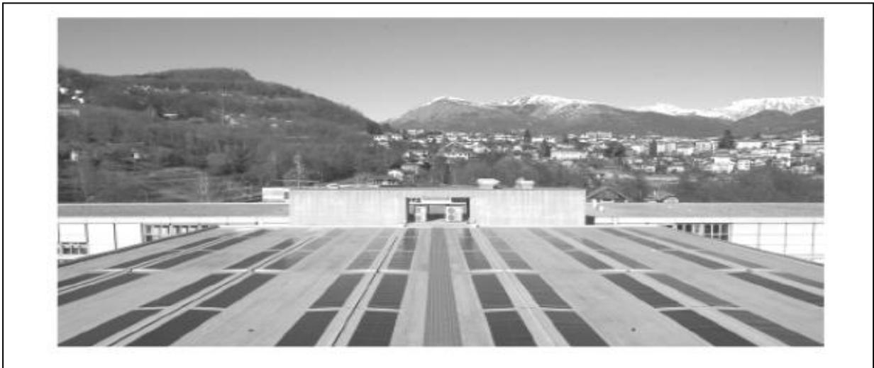
**Figure II.14 : Vue d'ensemble du système PV intégré à la toiture**
