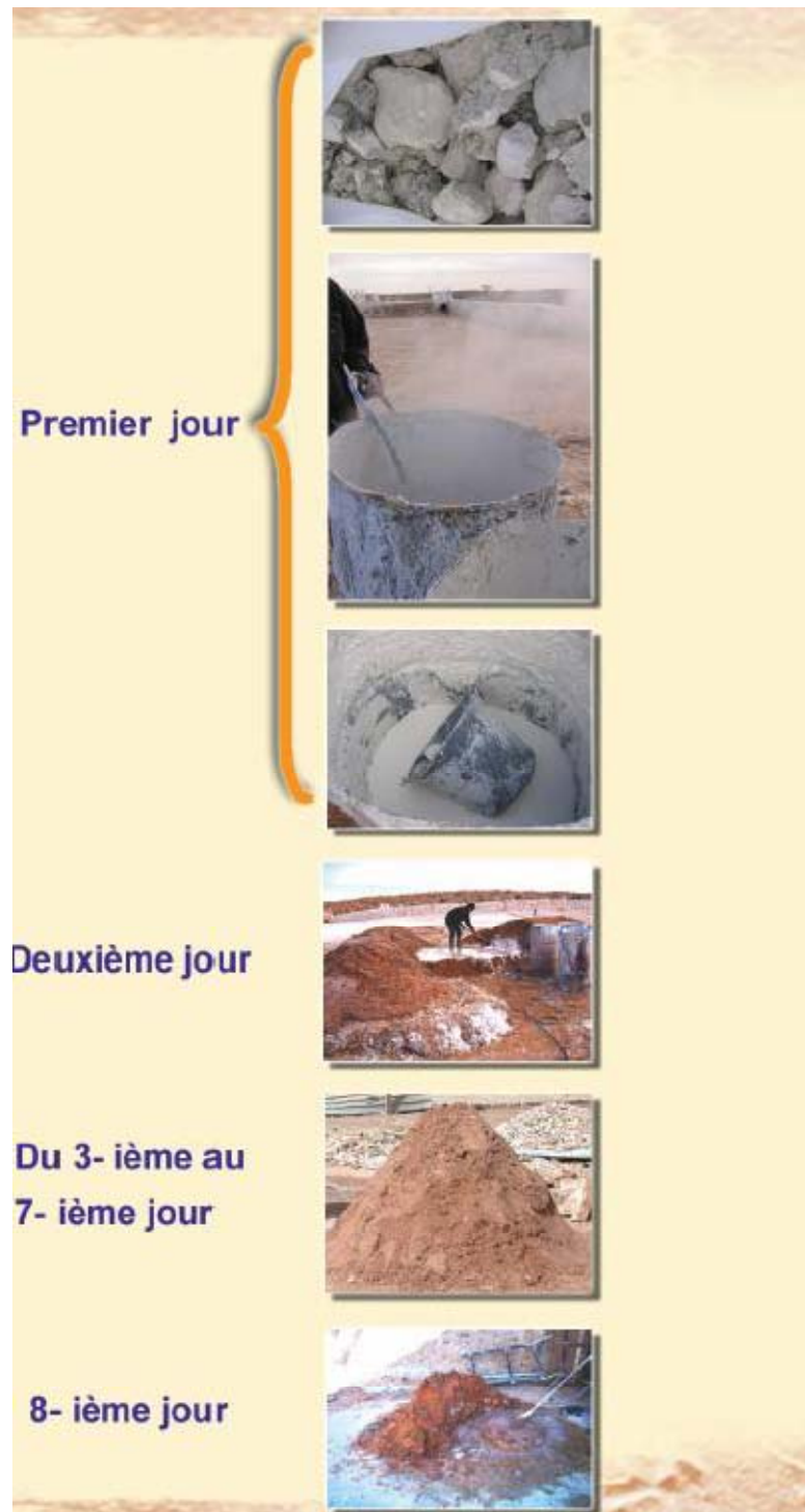
Figure 31 : Préparation du mortier de chaux [37].
