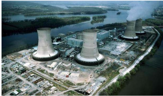
FIG. 1.16 – Centrale nucléaire de Three Mile Island au Etats-Unis
