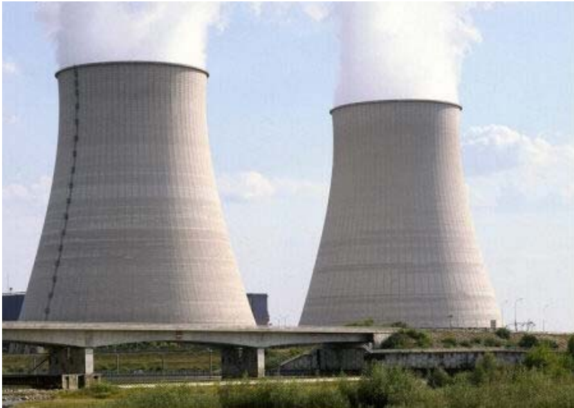
Tours de refroidissement de centrale nucléaire.
