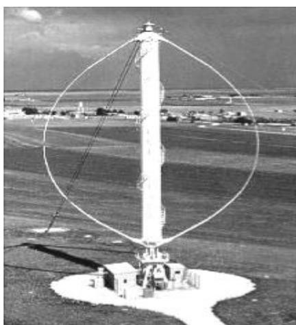
Figure (1-12): Schéma du rotor de Darrius [1].
