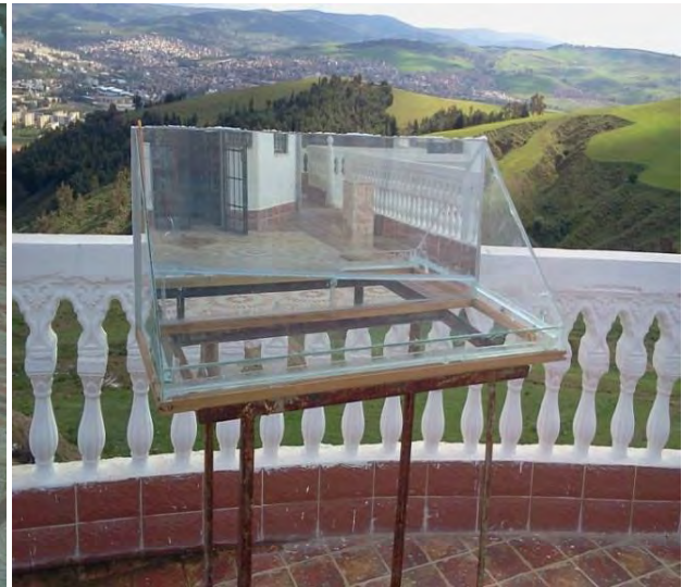
Figure 58 La couverture en verre après amélioration (ajout d'une gouttière et d'un isolant thermique)
