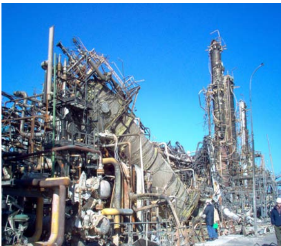
Figure II.13: Explosion de la chaudière Clark Chapman à Skikda.
