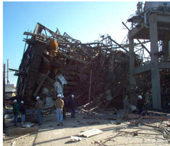
Figure II.13: Explosion de la chaudière Clark Chapman à Skikda.
