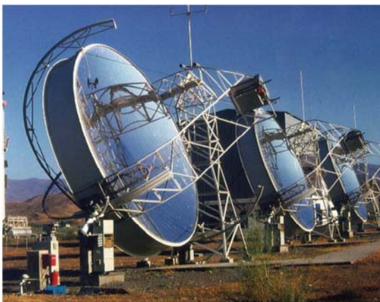
Figure 3.27 – Système Dish/Stirling avec la poursuite équatoriale
