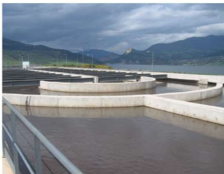
Figure 12: La zone anaérobie du réacteur biologique de la station de Sidi Merouane.
