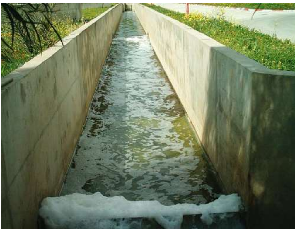
Figure 22 : Canal des rejets de la station d'épuration de Sidi Meroaune.
