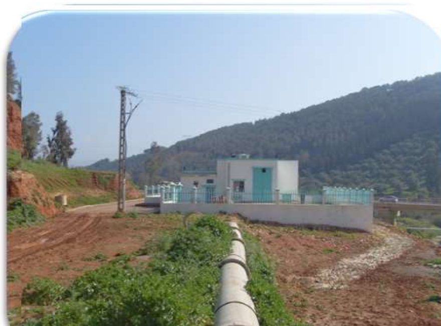
Figure 7: Conduite principale des eaux usées qui alimente la station d'épuration de Sidi-Merouane.
