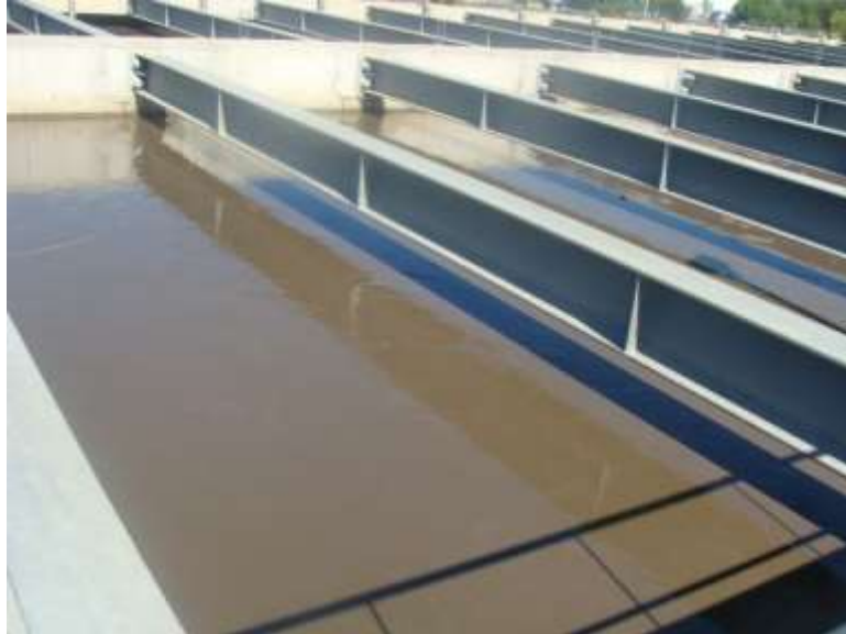
Figure 13: La zone aérée dans le chenal du réacteur biologique de la Station de Sidi Merouane.
