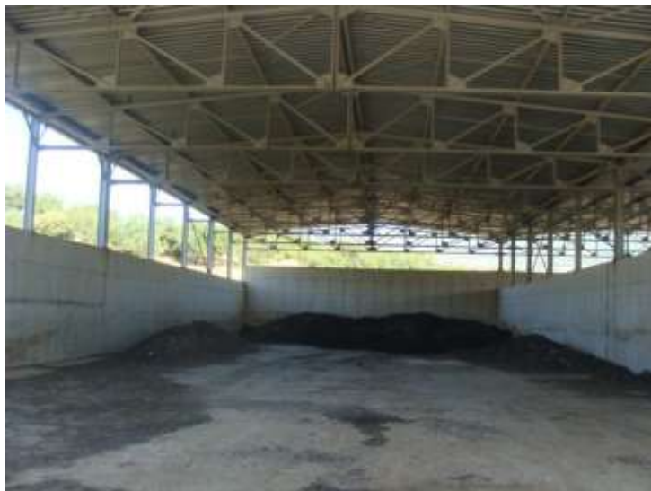
Figure 21: Aire de stockage des boues sèches de la station de Sidi Merouane.
