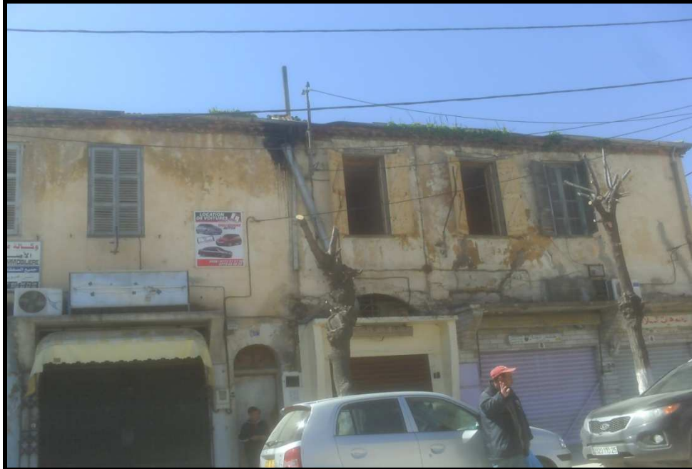
Photo 34 : Habitation en état de dégradation avancée sur la RN03
