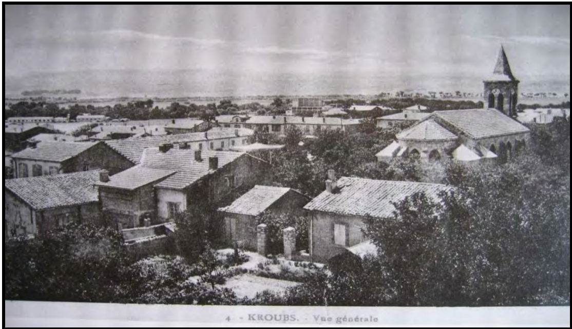
Photo 19 : Vue générale du noyau colonial.
