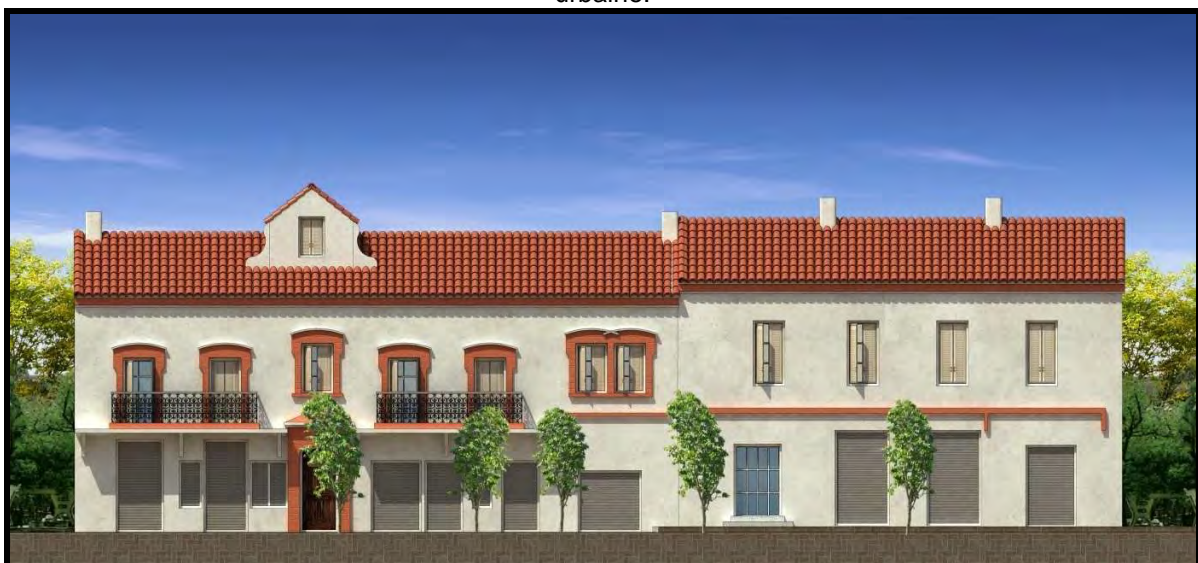
Image n°4,5 et 6 : Réfection par la pose de nouveaux revêtements donnant un aspect meilleur à la façade urbaine.
