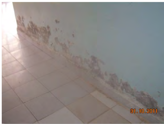
Photos N°33 et N°34 : Humidité et moisissure dans le couloir et les chambres. / Source auteur (2011)
