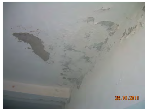
Photos N°33 et N°34 : Humidité et moisissure dans le couloir et les chambres. / Source auteur (2011)
