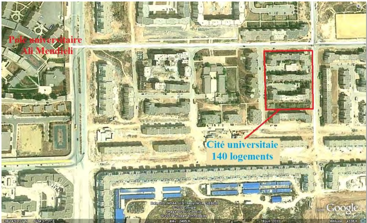
Figure N°19 : Cité Universitaire des 140 logements nouvelle ville Ali Mendjeli
