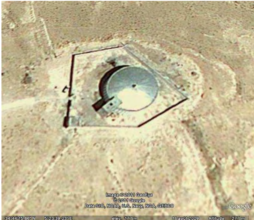
صورة رقم 05: خزان مائي شمال مركز بلدية طونقة
