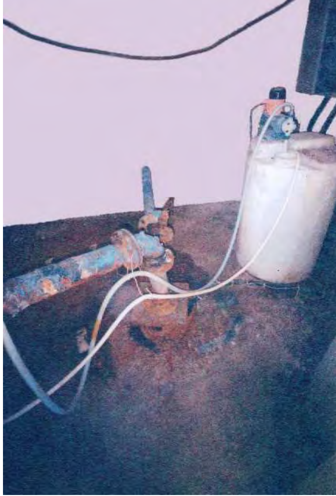
صورة رقم 04: معالجة المياه الموجهة للشرب بإضافة ماء الجافيل (منقب الدائرة)
