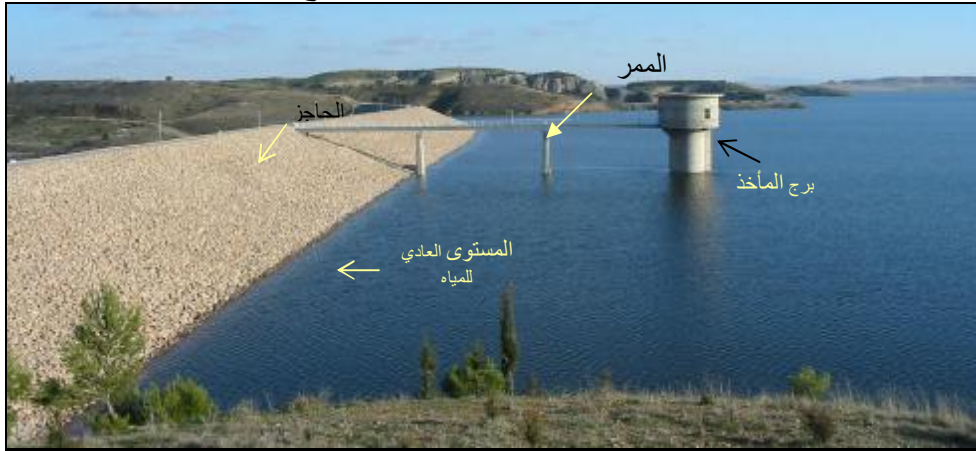
صورة رقم (08) نظرة عامة لسد عين زادة: الحاجز و برج مأخذ المياه.
