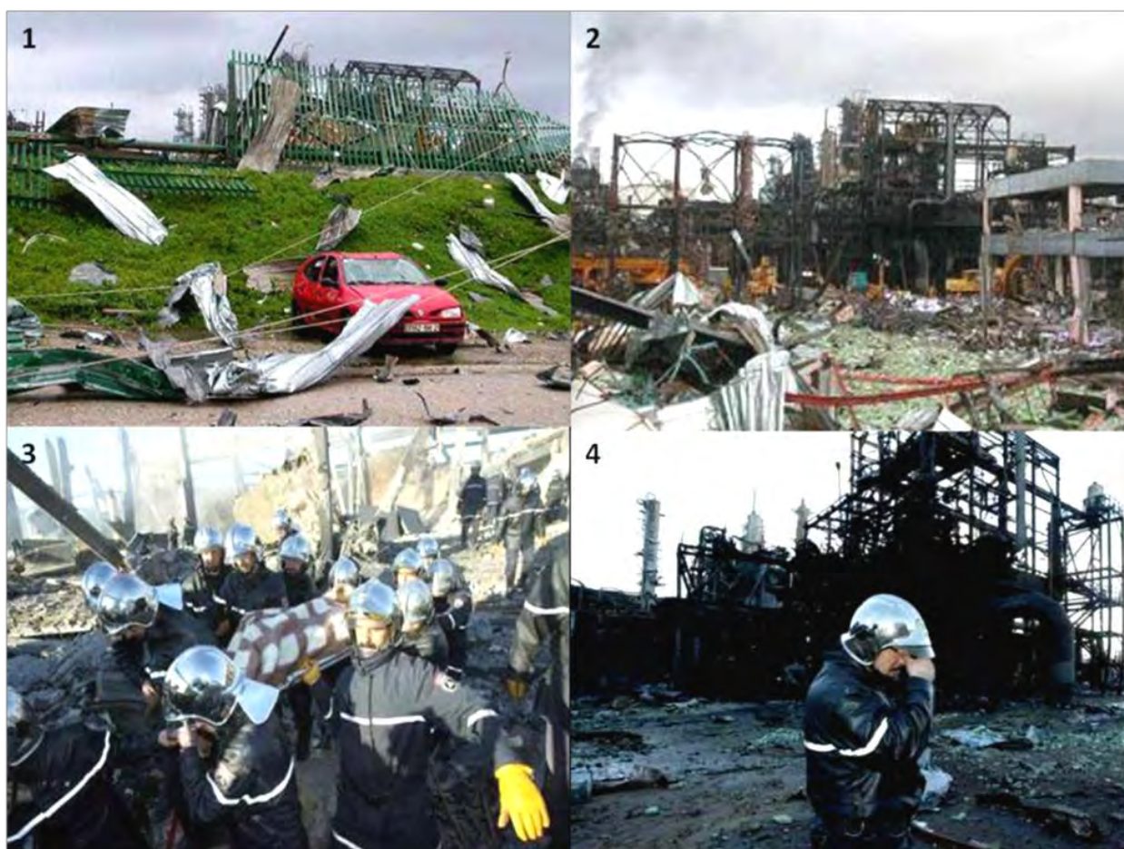
Photo 10. Les dégâts causés de l'accident de GN/IK
