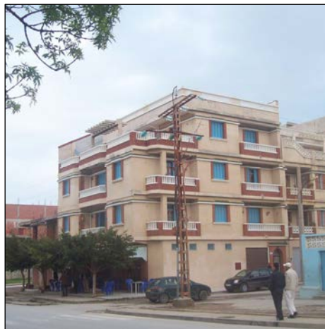
Photo N°108: Vue sur la façade
