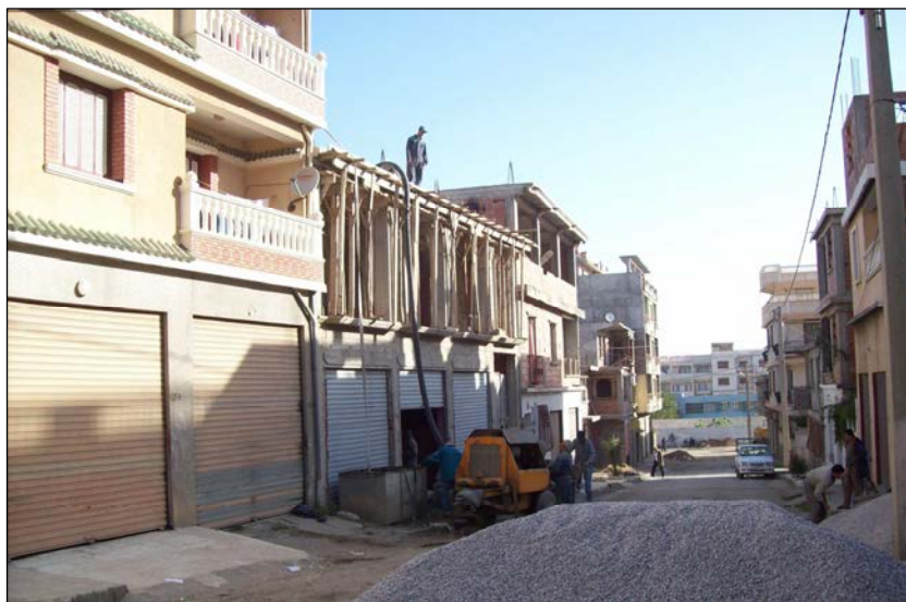
Photo N°46: Pompe à béton pour un coulage de dalle
