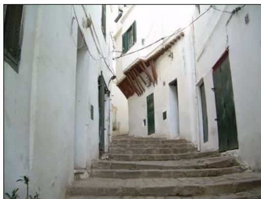
Photos N°02: Vue sur les murs extérieurs
