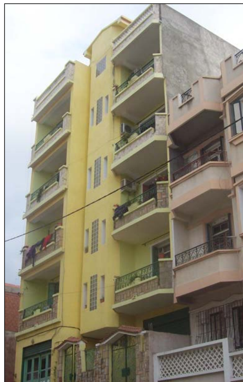
Photo N°75: Vue sur la façade
