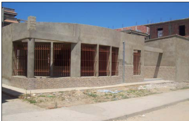
Photo N°47: Antenne APC en construction
