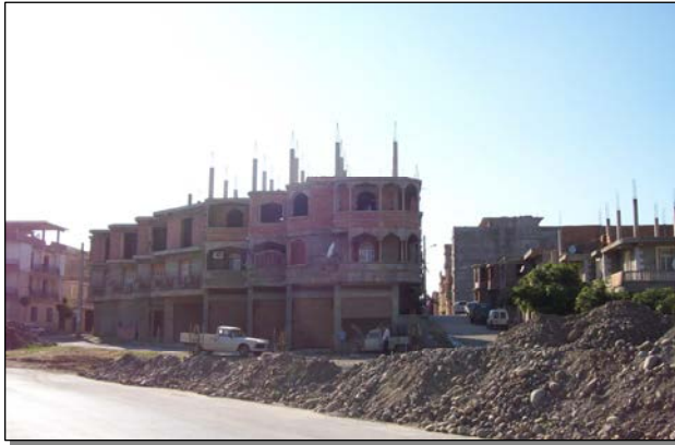
Photo N°44: Poteau en extension
