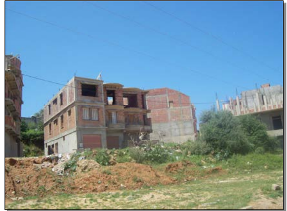
Photo N°45: Façade en brique dépourvue de crépissage
