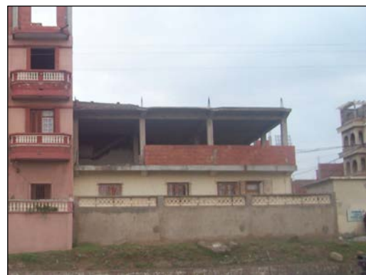
Photo N°122: Vue sur la façade
