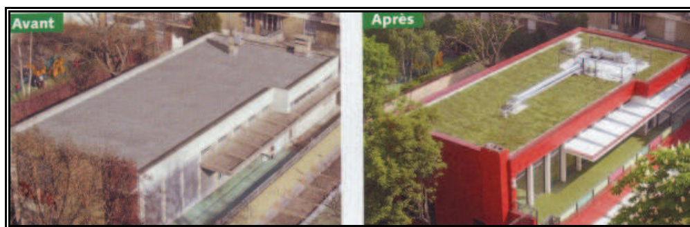
Figure III- 13. Végétalisation extensive de la terrasse inaccessible d'une crèche (à La Réunion) (Source. Soprema, brochure Sopranature, 2008)
