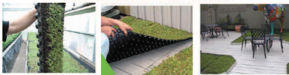
Figure II- 19. Tapis prévégétalisés (ELT System) (Source. Doug Banting et al., 2005)
