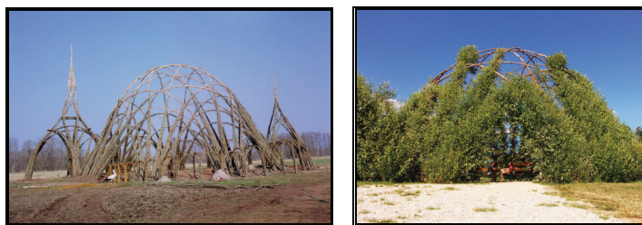
Figure I- 6 . A gauche structure en saule. A droite, végétalisation en lierre après une année (Allemagne, 2004-2005) (Source. www.wondertree.co.uk )
