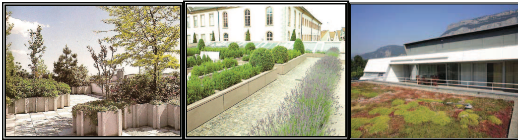
Figure II-1 .De gauche à droite : végétalisation intensive, semi- intensive et extensive. (Source. A gauche et milieu : Furlani, 1996- à droite : www.siplat.fr)
