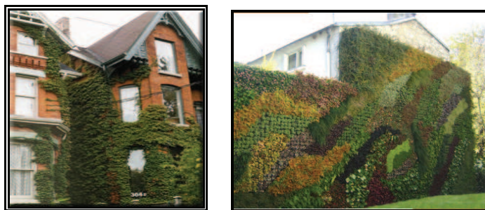
Figure I- 14. Façade recouverte d'un mur végétal (Source. A gauche : www.ec.gc.ca . A droite : www.canevaflor.com )
