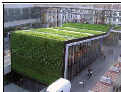
Figure I- 5 . Mur et toit végétal, Station de métro Flon (Lausanne, Suisse) (Source. www.canevaflor.com )
