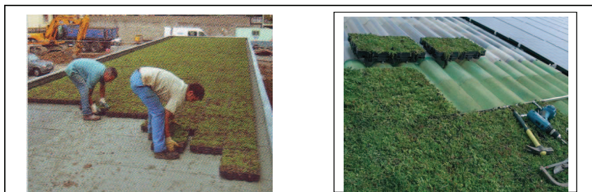
Figure II- 20. Bacs prévégétalisés à réserve d'eau sur toit plat ou en pente (Sources. A gauche ; Siplat, brochure, 2008- A droite ; Verdura, Eternit, brochure 2008)
