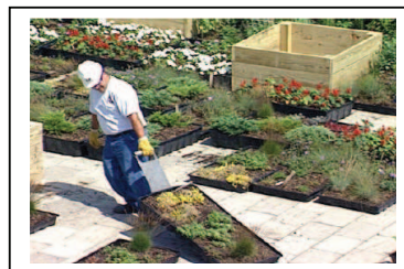
Figure II- 18. Système modulaire en plateau (Green Grid System) (Source. Doug Banting et al., 2005)
