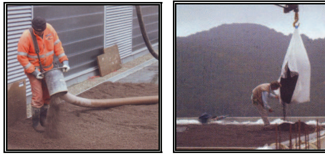
Figure II- 11. A gauche : Soufflage du substrat à l'état meuble. A Droite : Répartition manuelle du substrat meuble
