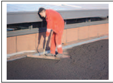
Figure II- 6. Drainage d'agrégat minéral (Source. www.vegetalid.com )
