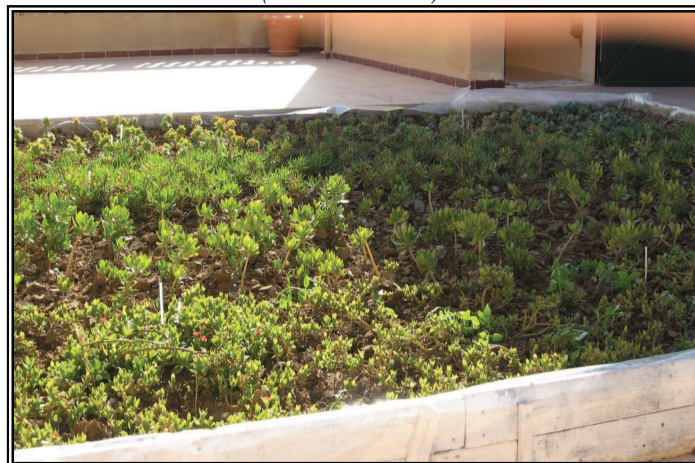
Photo V- 6. Aspect de la toiture végétale en novembre 2010. (Source. Auteur)
