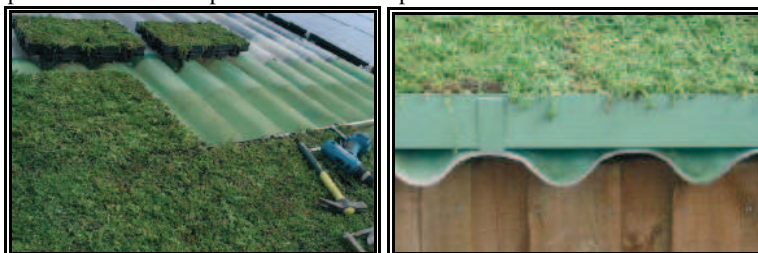
Figure III-1. A gauche : assemblage des bacs pré- végétalisés sur un toit en pente A droite. Cornière anti- glissement en bas de pente. (Source. Brochure Verdura, Eternit, 2008)
