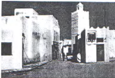
Figure 5-31 : Exemple de Kairouan (Tunisie), réponse au fort rayonnement solaire par l'utilisation extrême de la chaux blanche en enduit extérieur. (La couleur blanche des murs a pour effet d'éviter leur échauffement en réfléchissant le rayonnement reçu et de rendre leur bilan thermique « négatif »
