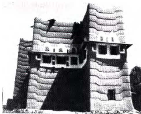
Figure 5-29 : Exemple dans l'architecture traditionnelle du Yémen. Source : IZARD.J.L, 1993. Efficacité de la protection solaire par les éléments de la façade (décrochement en lamelle horizontale, pour l'ombre de la façade).
