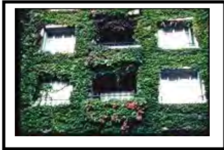
Figure 4-21 : Traitement de la façade OUEST.
