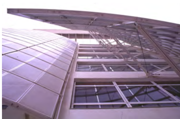
Figure 5-38: Le vocabulaire de l'architecture high-tech lui permet de disposer de moyens importants pour la protection solaire des façades, comme ici au siège d'Expo 98 à Lisbonne, où la façade Ouest est entièrement doublée par son système pare-soleil en métal perforé.
