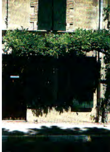
Figure 5-30 : Réponse vernaculaire à la protection solaire avec un effet d'auvent « la treille »
