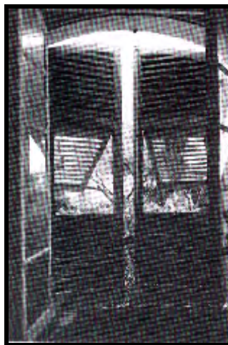
Figure 5-42 : Des persiennes utilisées dans les régions méditerranéennes pour le contrôle solaire et la ventilation.
