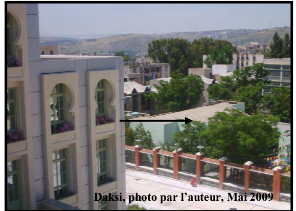
Empiètement du nouveau siège de la wilaya sur l'espace d'extension du centre culturel
