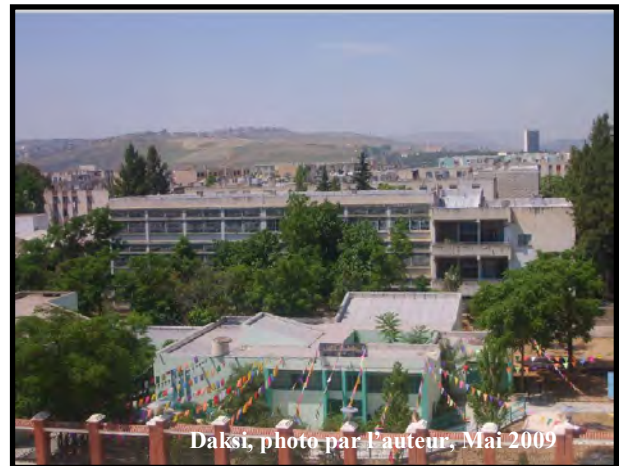
Centre culturel du quartier, équipement existant : l'extension programmée par le POS, n'a pas eu lieu.
