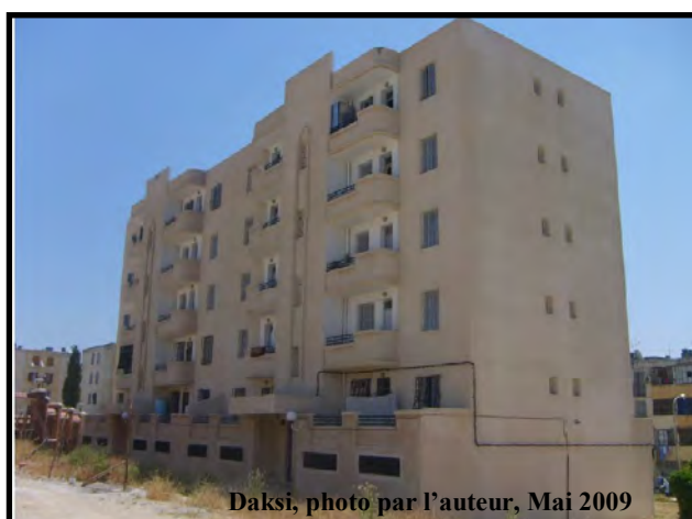
Les 20 logements LSP.
