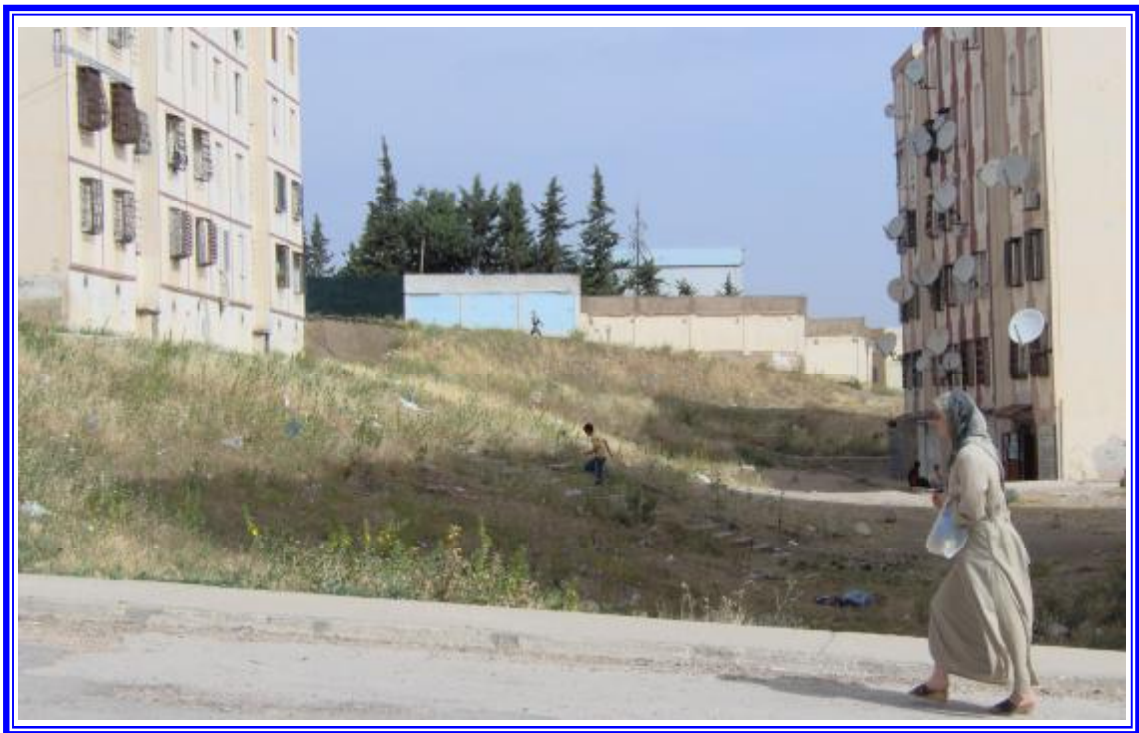
Photos n°6 : Espace libre à l'intérieur des îlots ; nu et à l'état brut. Source : Auteur.
