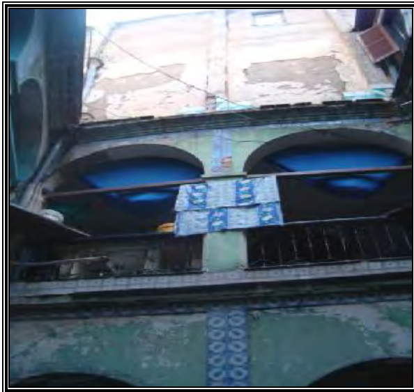
Fig.6-9 : 1 er corps de bâtiment : la maison El-âaly, Surmontant E'dar. Source : auteur (2005)
