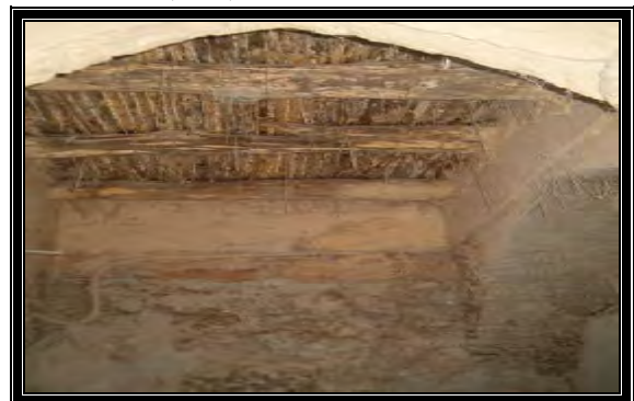
fig.6.33 : structure d'un plancher en bois (genévrier) Source : auteur (2005)
