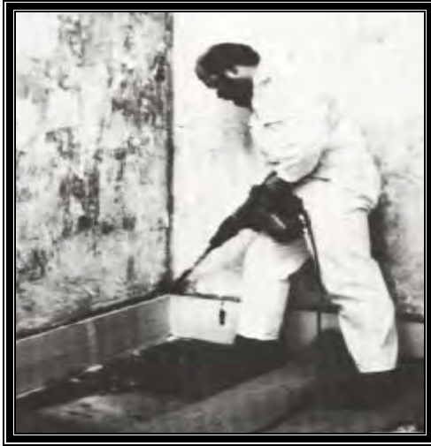
Fig. 4-22 a : percements de trous obliques
