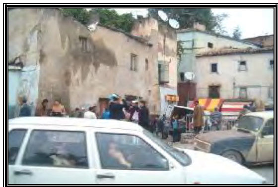
Fig.3.6 : Infiltration directe par le mur extérieur dans D'une maison vernaculaire à Suika
