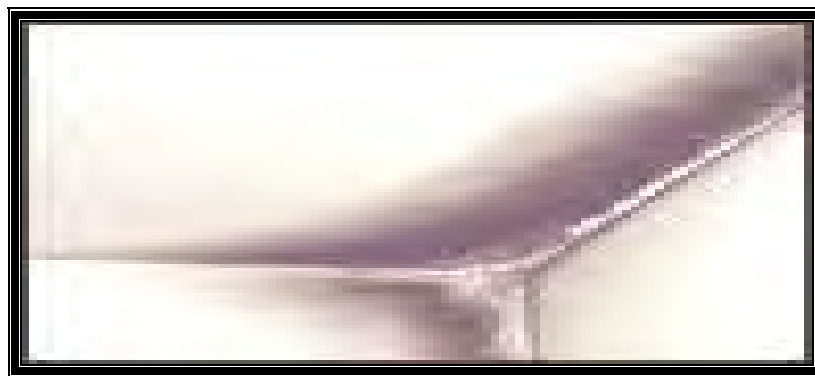
Fig. 4-2 : condensation dans les bâtiments en béton armé, Pont thermique au niveau de la colonne d'angle. Source : www.travaux.com , 2005
