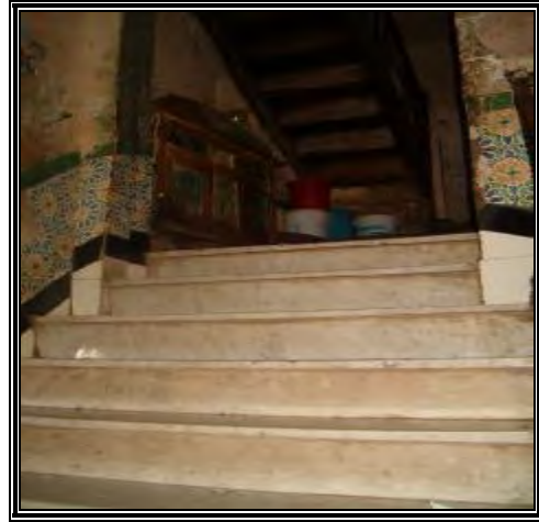
Fig. 6-37 : escalier principal assurant la relation verticale entre galeries
