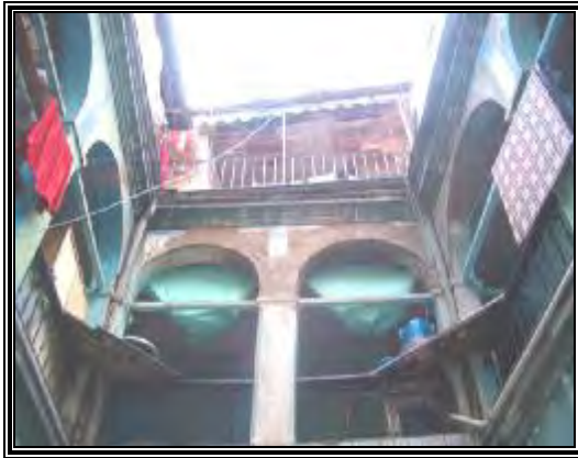
Fig.15: patio ouvert vers le ciel
