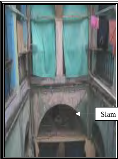
Fig.6.13 : Slam au 2 e niveau Source : auteur (2005)
