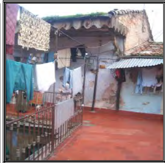
Fig.6-28: Buanderie, transformée en logement
