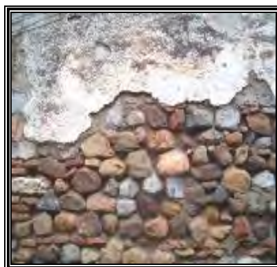
a) Mur en pierre
