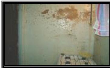
Fig.3.7: La condensation superficielle Fig.3.8 : Effet de la vapeur de cuisine Fig.3.9 : La condensation interne Source : auteur, 2005
