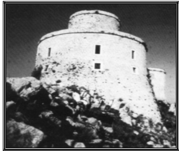
Fig. 4-8 : les bâtisses situées sur les sommets des collines attaquée par l'humidité s'explique seulement par le phénomène de la condensation tellurique
