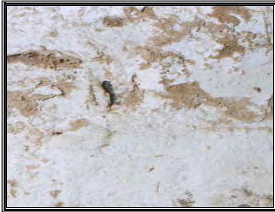
Fig.3.21 : Efflorescences. Source : auteur ,2005
