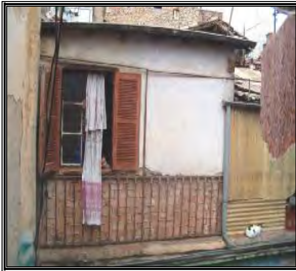
Fig.6-27 : construction précaire et illicite (habitée)
