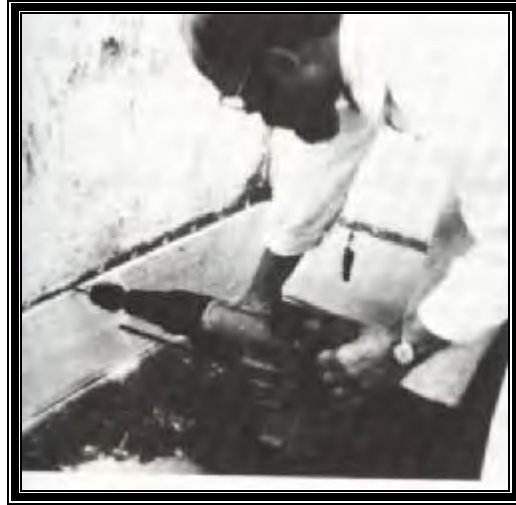
Fig. 4-22 b : percements de trous horizontaux
