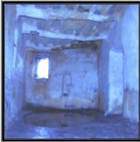
a) fenêtre ouvrant sur la rue de dim : (0,40/0.50)
