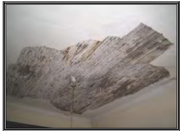
Fig.6-20 : faux plafond dégradé (Skifa)
