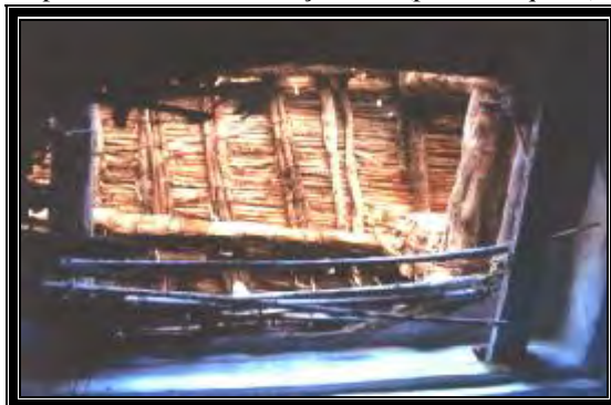
fig.6-32 : structure d'un comble en bois (genévrier)
