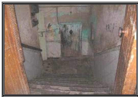
Fig.6-18 : différence de niveau marquant le seuil de la skiffa
