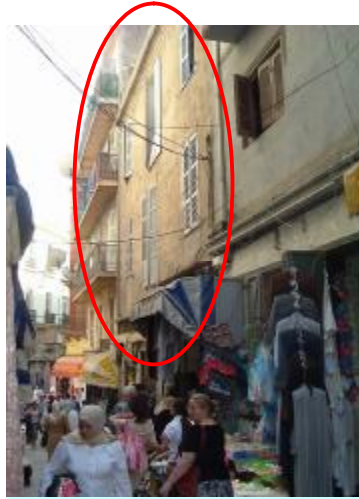
Photo.22: Exemple de baies qui se détachent sur un mur exempt de tout relief, façade de la rue de France Source : Auteur, 2004.
