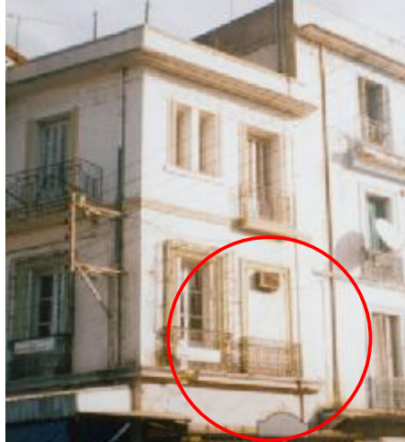
Photo.27 : Exemple de baie murée sur le parcours de Annaba Source : Auteur, 2004.
