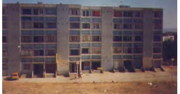
Photo 2 : Arrière du Bâtiment
