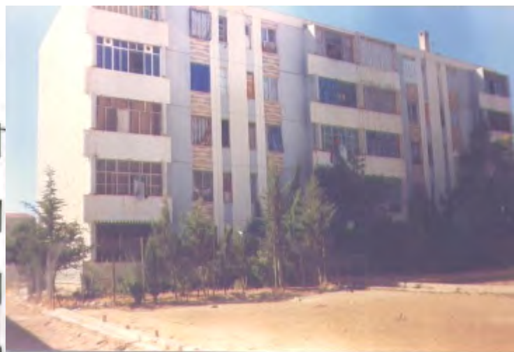
Photo : Arrière du bâtiment
