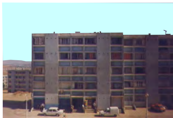
Figure 70 : Photo - vue plongeante sur la Façade et la cours Anglaise.
