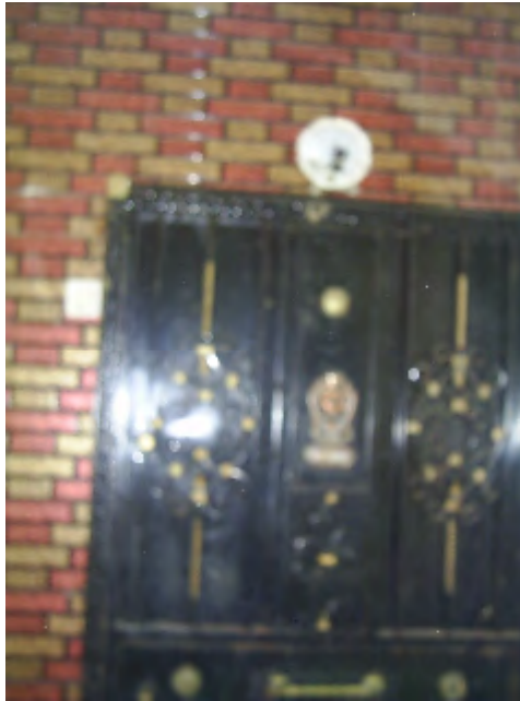
Figure 77 : Renforcement et Embellissement de la porte d'accès au logement.
