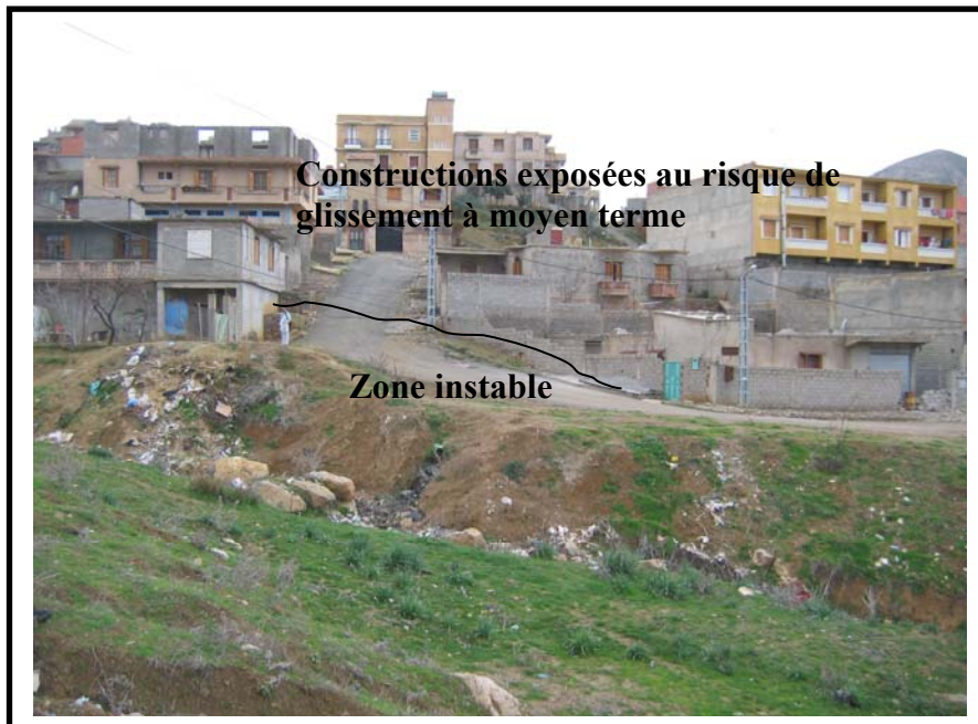
Photo 2. L'ensemble du versant est exposé au risque de glissement, par évolution de la zone instable aval
