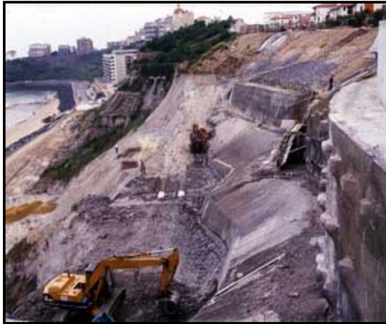
Fig. V-1 : Travaux de terrassement
