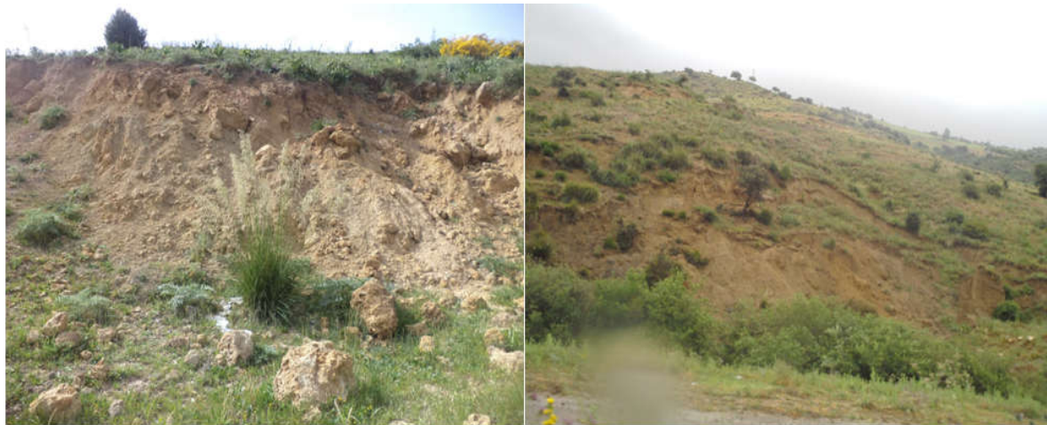
Photo III.2 : Glissement de terrain affectant les marnes argileuses du miocène moyen-supérieur ; 36°13'15,59"E, 7°51'36,52"N /RN 81, PK 88 ».
