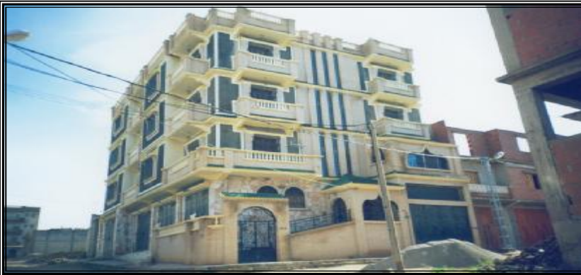
صورة رقم:(01) التعدي على المساحة المبنية المحددة في دفتر الشروط في تحصيل الوفاء (تم البناء على كل المساحة العقارية)
