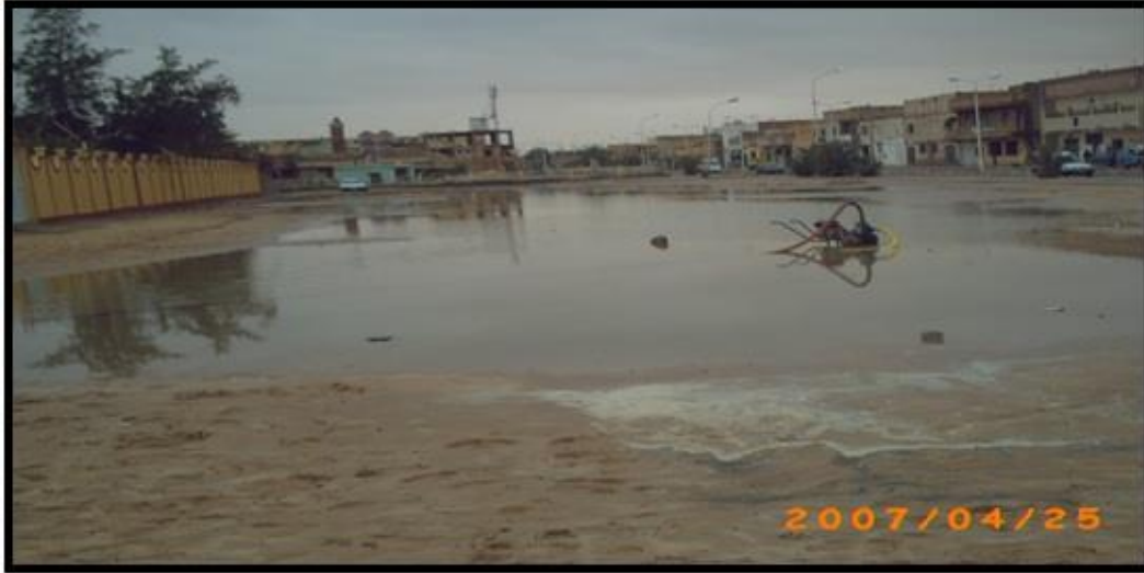
الصورة رقم(22): استعمال المضخات للتخلص من مياه الامطار الفجائية -تبسبست -
