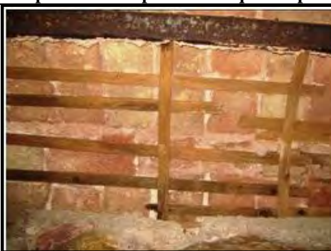
photos 90 : vue sur un plancher au niveau de la cave.
