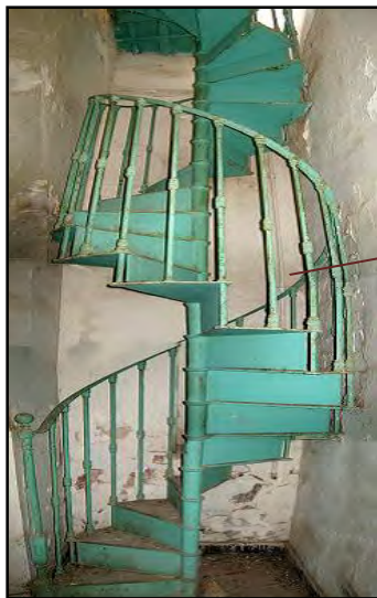
photos 100, la cage qui lie l'étage a la terrasse
