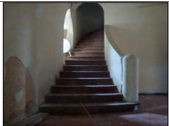
photos 99 la cage d'escalier qui lie le RDC avec l'étage
