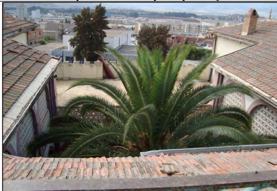
photos 64 : vue du palais du haut de la toiture
