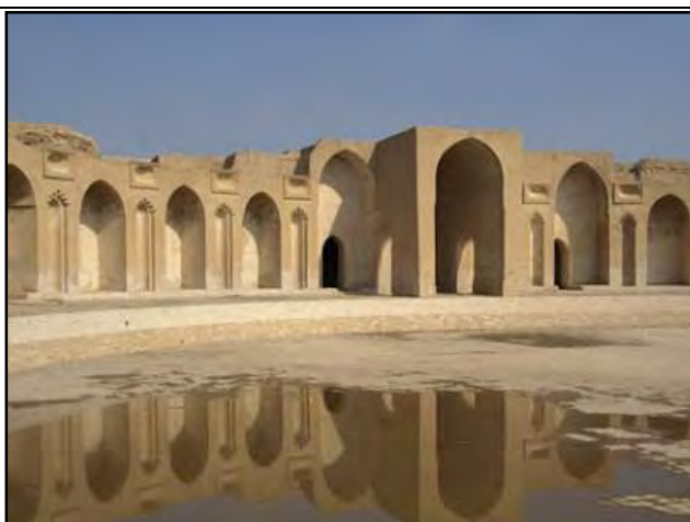
photos 9 : vue intérieure sur le large serdab
