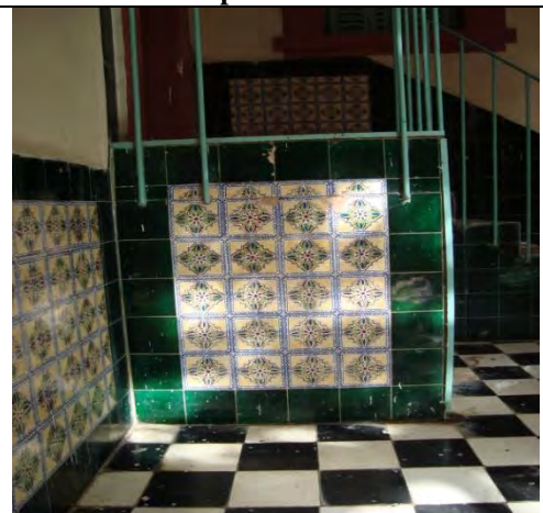
photos 133, reprise de la faïence détachée, par une plus récente
