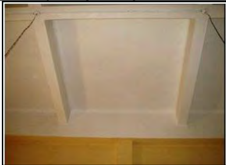
photos 91: vue sur une dalle en caisson
