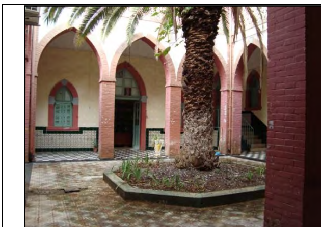
photo 65 accès a la salle de lecture au RDC du palais.
