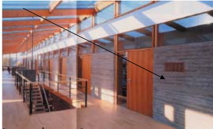
Figure 18 Vue intérieur du bâtiment et des sorties d'air à travers les murs en pisé (source craterre)
