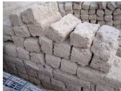
Figure 99. Type de mur porteur en briques de terre , confectionnées sur site
