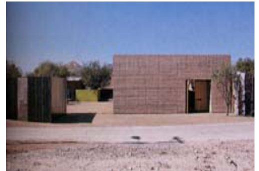
Figure 14 vue générale sur le projet (source : craterre)
