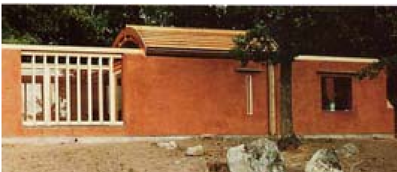
Figure 17 vue sur le projet réalisé . (source craterre.fr)
