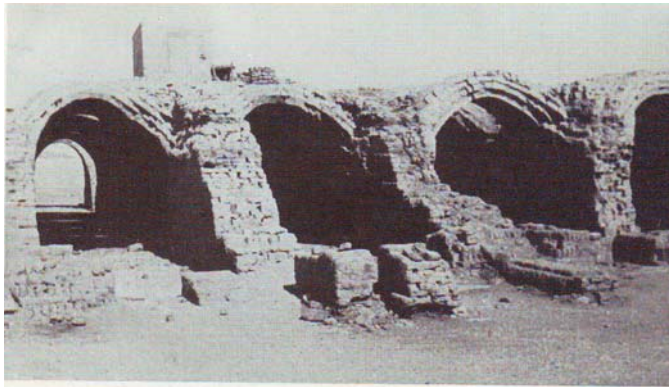
Figure 10 des voûtes égyptiennes réalisées sans coffrage, un savoir faire antique.
