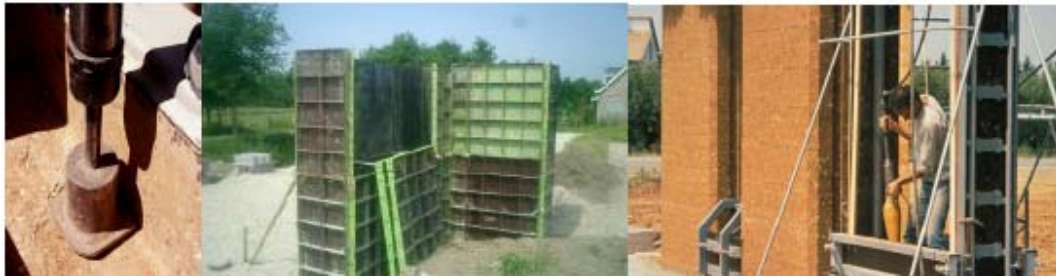
Figure 36 Coffrage métallique et moyens de compactages (source: craterre)
