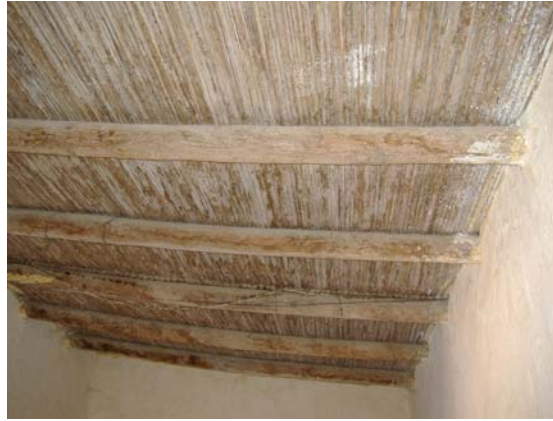
Figure 101 détail du plafond de la pièce objet de l'investigation, compose d'elements en bois.
