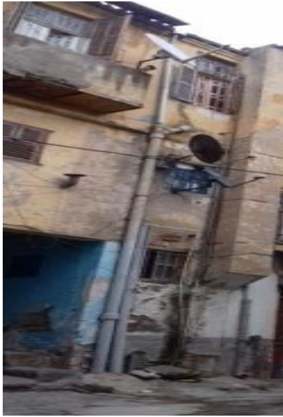
Photo n°77 : Maison n° 7 rue Abdelhamid Ben Badis réhabilitée par son propriétaire Source : Auteur 2019
