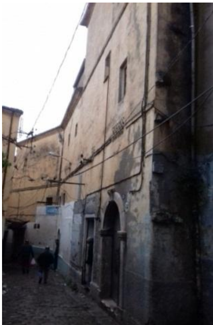
Photo n°68 : Maison n°32 de la rue Salah Tahar refaite par son propriétaire Source : Auteur 2019
