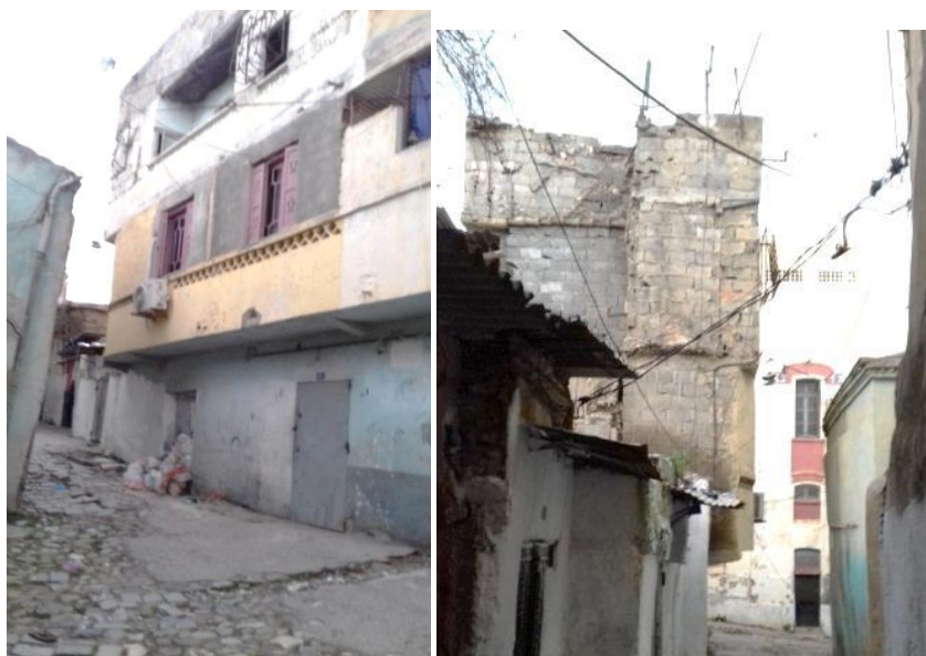
Photo n°86 : reconstruction de la maison n°16 rue Bendjelloul Abdelmadjid Source : Auteur 2019
