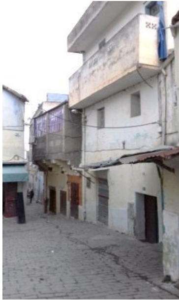
Photo n°80 : De gauche à droite maison n° 02 et n° 04 de la place Sidi Djelis transformées par leurs propriétaires Source : Auteur 2019
