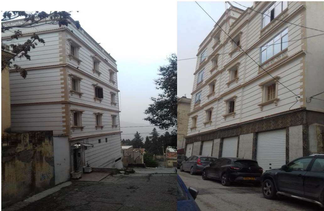
Photo n° 94 : Façades d'un pavillon colonial qui montrent une mutation agressive par la reconstruction au style ordinaire avec des locaux commerciaux en RDC Source: Auteur 2020
