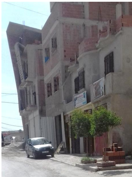
Photo n°13 : Entreprise a côté d'un atelier d'artisanat dans la cité Belhadj Auteur 2019
