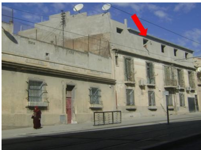
Photo n° 97: Maison transformée par le rajout d'un étage Source : Auteur 2014
