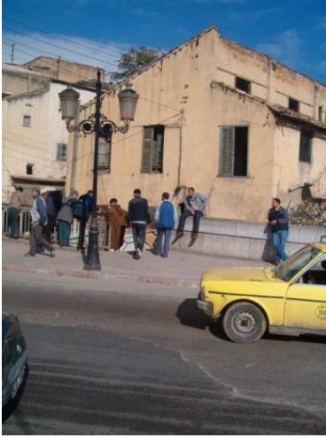
Photo n°46 : Etat de la mosquée avant la réhabilitation
