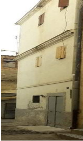
Photo n°66 :Maison n°6 de la rue Bouhala Amar refaite par son propriétaire au style traditionnel Source : Auteur 2019
