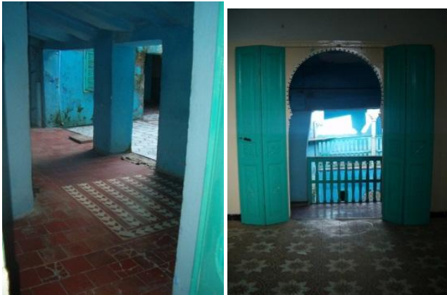
Photo n°27 : Etat de la maison avant le projet de la réhabilitation.
