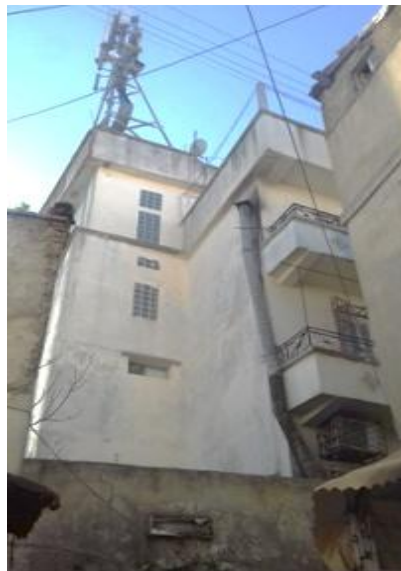
Photo n°85 : Une reconstruction au style ordinaire de la maison n°4 rue Abdelaziz Source : Auteur 2019
