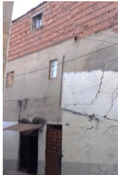
Photo n°81 : Maison n°2 Rue Ben Souiki transformée par son propriétaire Source : Auteur 2019
