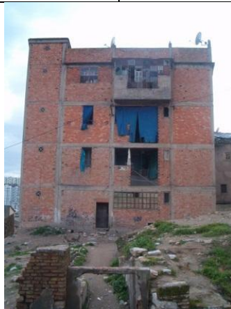
Photo n°72 : Maison n°28 rue Bakhouche Abdeslem reconstruite au style ordinaire Source : Master plan 2003
