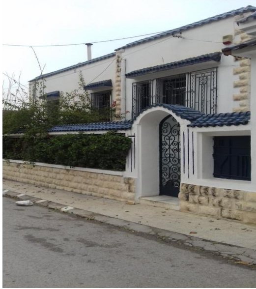
Photo n° 93 : Reconstruction de type maison terrasse sans tuile Source : Auteur 2020
