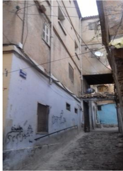
Photo n°78 : Maison n°3 Derb BenCharif réhabilitée par son propriétaire Source : Auteur 2019
