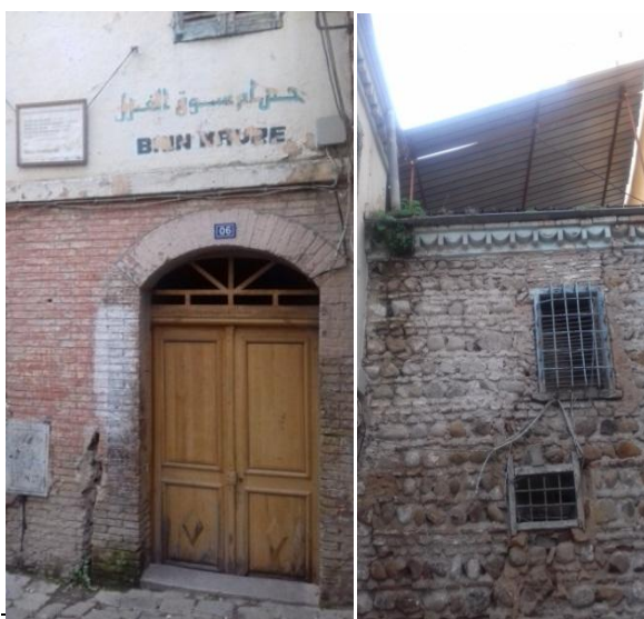
Photo n°53 : Etat de hammam Laghzel
