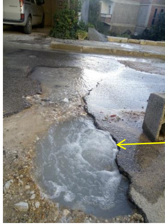
صورة 36 تسرب قوي لمياه الشرب بتخصيص الحياة
