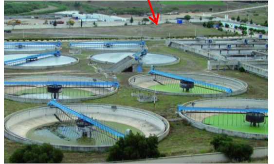
صورة (7) أحواض التصفية بالمحطة
