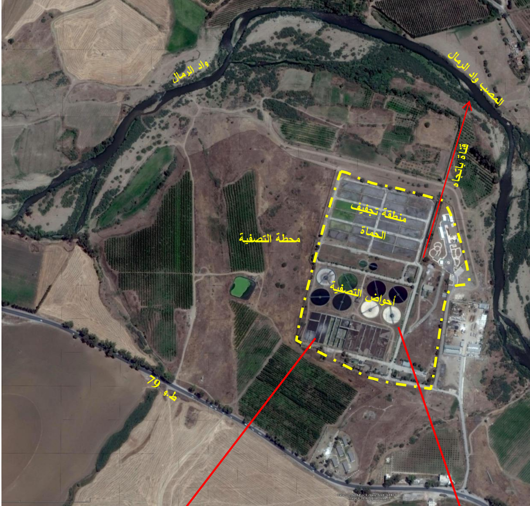
صورة (6) محطة معالجة مياه الصرف الصحي ابن زياد
