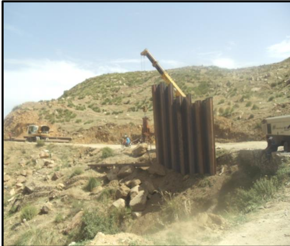
صورة رقم (19): أعمال صيانة ضد الانزلاقات الأرضية على الطريق الوطني رقم 77 الرابط بين بلدية جيملة وبلدية بودريعة بني ياجيس. (تحقيق ميداني سبتمبر 2012)
