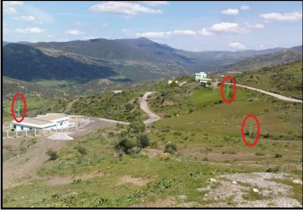
صورة رقم (26): انتشار أعمدة الكهرباء، مشقة قليب الديس. بلدية غباله ميلاط
