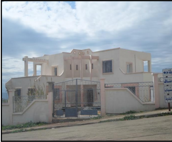
صورة رقم (45): عيادة متعددة الخدمات (حديثة) - بلدية حمالة - (تحقيق ميداني. مارس 2013)
