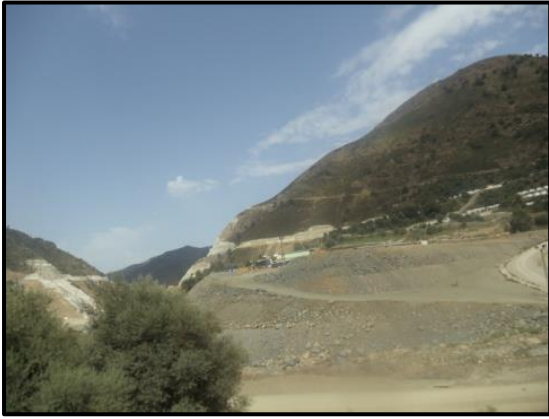
صورة رقم (09): أشغال مشروع سد تابلوط - بودريعة بني ياجيس-
