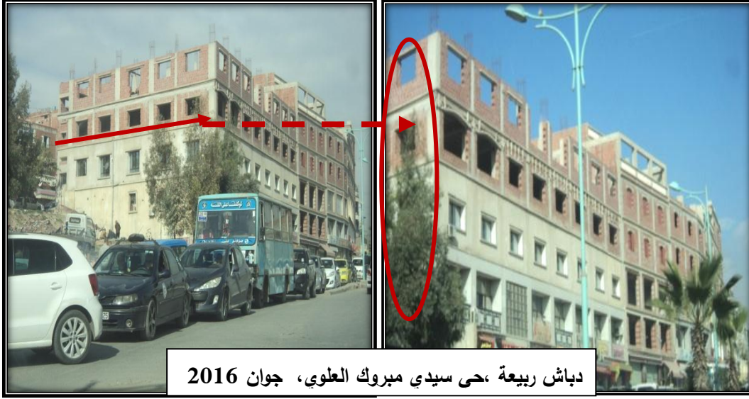
الصورة رقم (60): بناء القطعة كاملة (100%) (النطاق العمراني الثاني)
