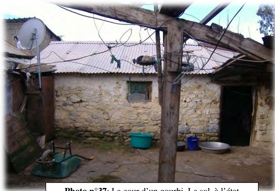
Photo n°37: La cour d'un gourbi. Le sol, à l'état naturel et la toiture en tôle de zinc ondulée sont propres. Source : l'auteure, 2010.
