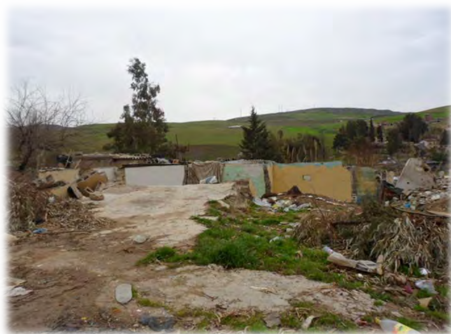
Photos 56/57: Des baraques non démolies entièrement ou reconstruites, Site Djaballah. Source: Auteure, 18 mars 2015
