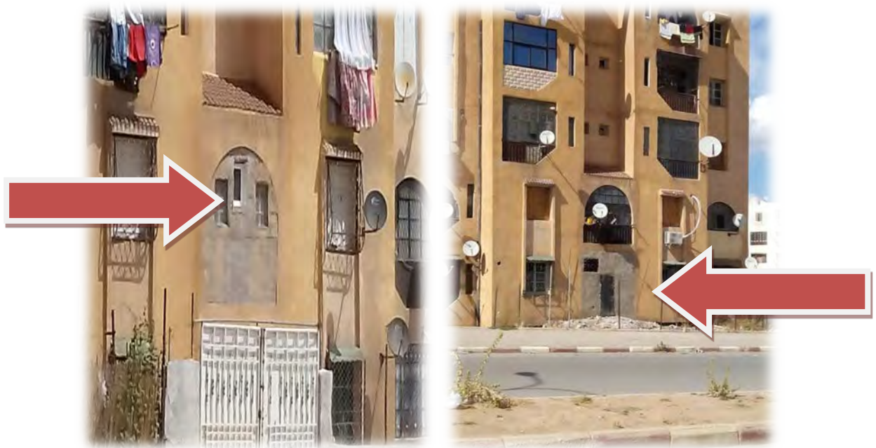
Photos n°60/61/62: Ville Ali Mendjeli : balcons transformés: l'un en 3 petites lucarnes et l'autre en porte d'entrée du logement.
