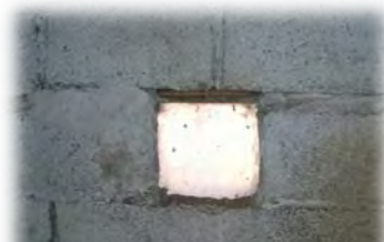
Photo n°53: En guise d'aération, ouverture dans le mur de la ''cuisine'' Source: Auteure, Avril 2011
