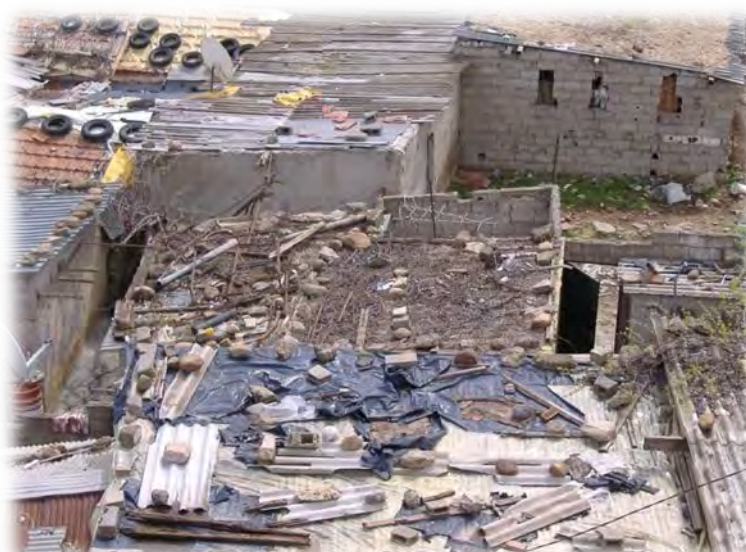
Photo n°25/26: Les toitures des baraques Des pierres, des planches et des pneus pour la renforcer Source: l'auteure, 2012.
