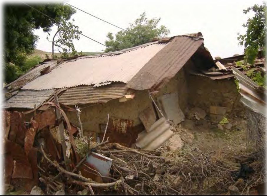
Photo n°33 : Une baraque construite en 1958. Les tuiles en eternit et en tôle de zinc en guise de toiture. A la voir de la sorte on pourrait croire qu'elle s'est effondrée et n'est pas habitée. L'entrée qui n'est pas visible est située à gauche en face des arbres. Source : l'auteure, 2010.
