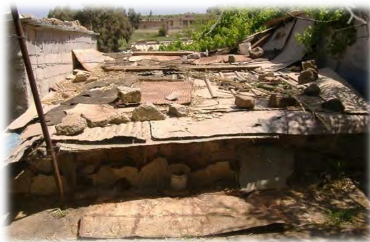
Photos n°47/48: La toiture en tôle de zinc ondulée renforcée par de grosses pierres. Source : Auteure. Avril 2011
