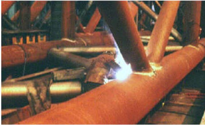
Fig.I.21 Soudage d'éléments tubulaires
