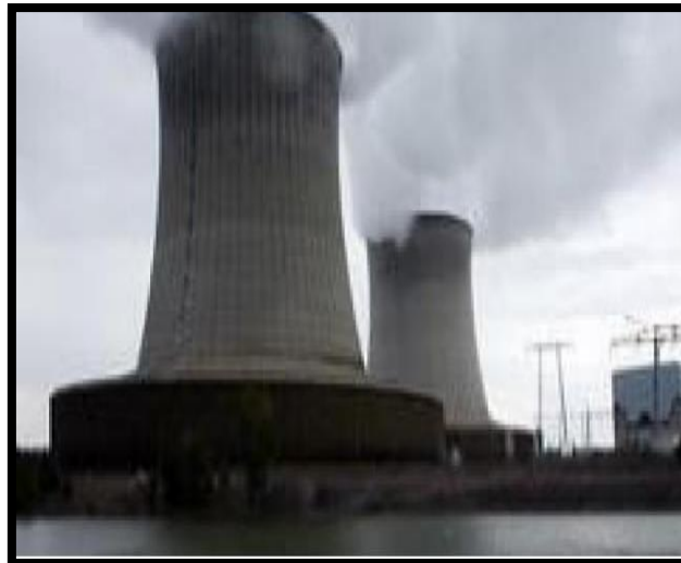
Fig. 1.13 : Centrale nucléaire Civaux –France
