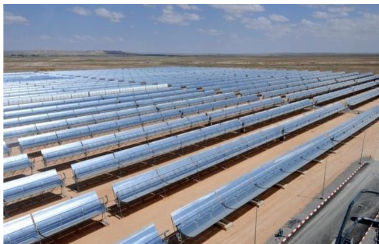
Figure II.3. Champ de collecteurs cylindro-paraboliques
