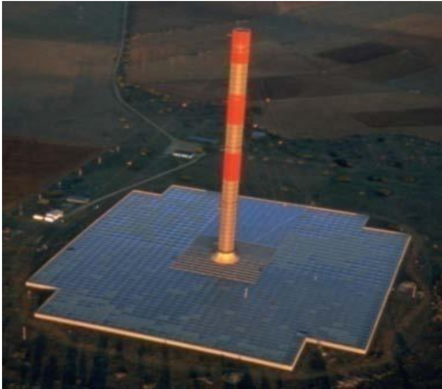
Figure II.6. Configuration de la cheminée solaire [2.11]
