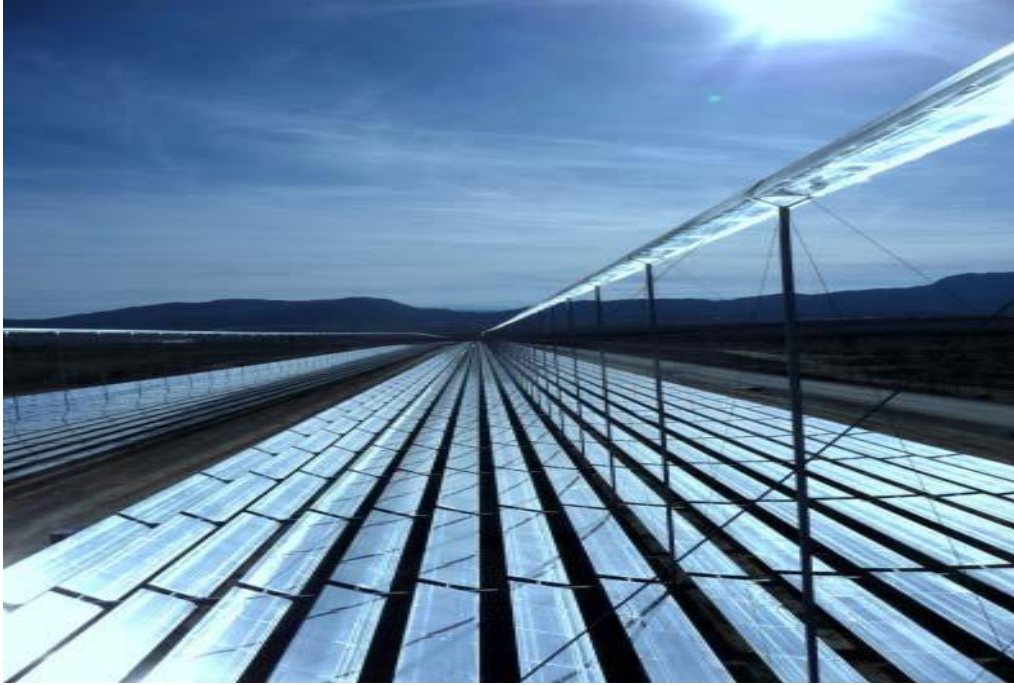
Figure II.5. Concentrateur solaire de Fresnel linéaire [2.9]
