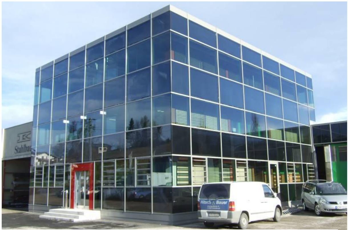
Figure A-2-2 : intégration PV/T sur façade Le bâtiment de bureau se situe à St. Schörfling, Autriche et possède 162m 2 de Capteurs solaires en façade double enveloppe.
