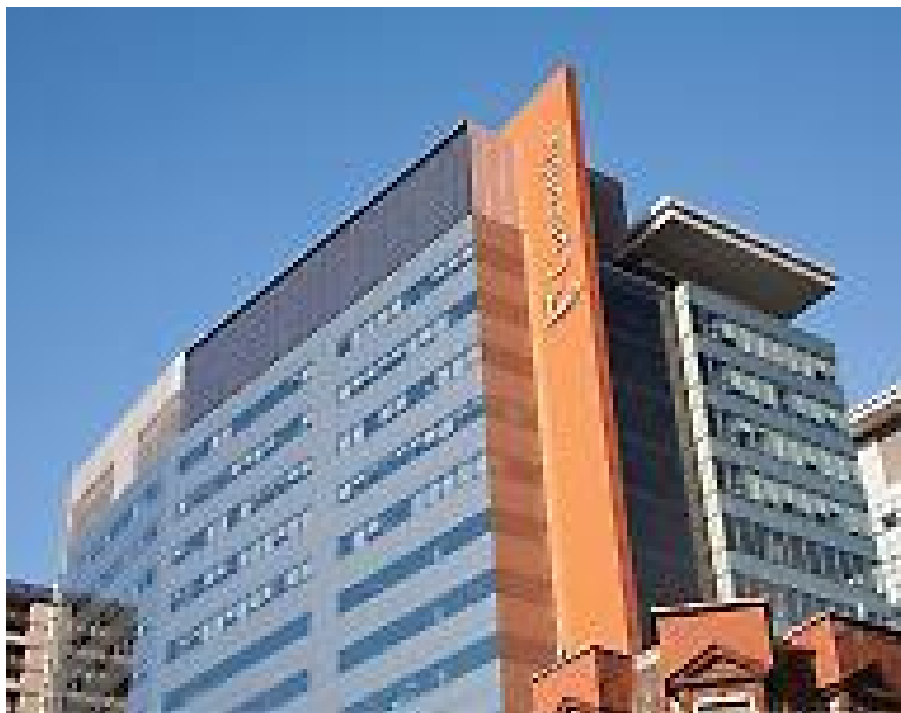
Figure A-2-2 : intégration PV/T sur façade Le bâtiment de bureau se situe à St. Schörfling, Autriche et possède 162m 2 de Capteurs solaires en façade double enveloppe.
