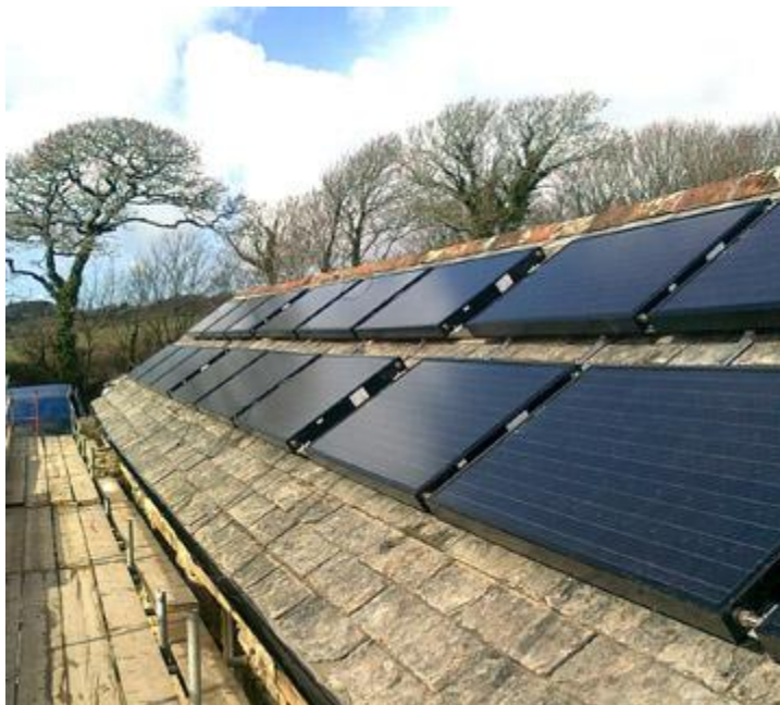
Figure A-2-1 : intégration PV/T sur la toiture
