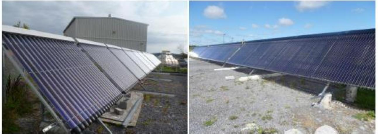
**Figure 3.2 : Capteurs solaires sous vide utilisées dans l'installation (deux rangées)**
