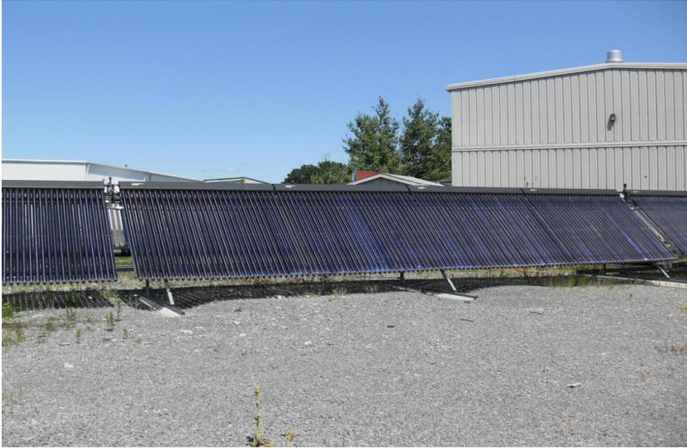
**Figure 3.13 : Champ de capteurs solaires sous vide – vue de face d’une seule rangée**
