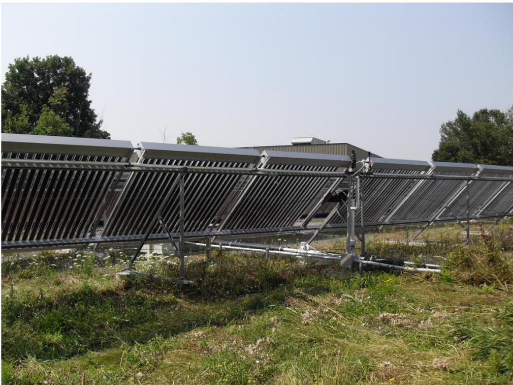
**Figure 3.14 : Réseau de canalisation pour capteurs sous vide**
