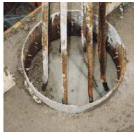
Figure 1-1 : Exemples de poteaux mixtes [2].
