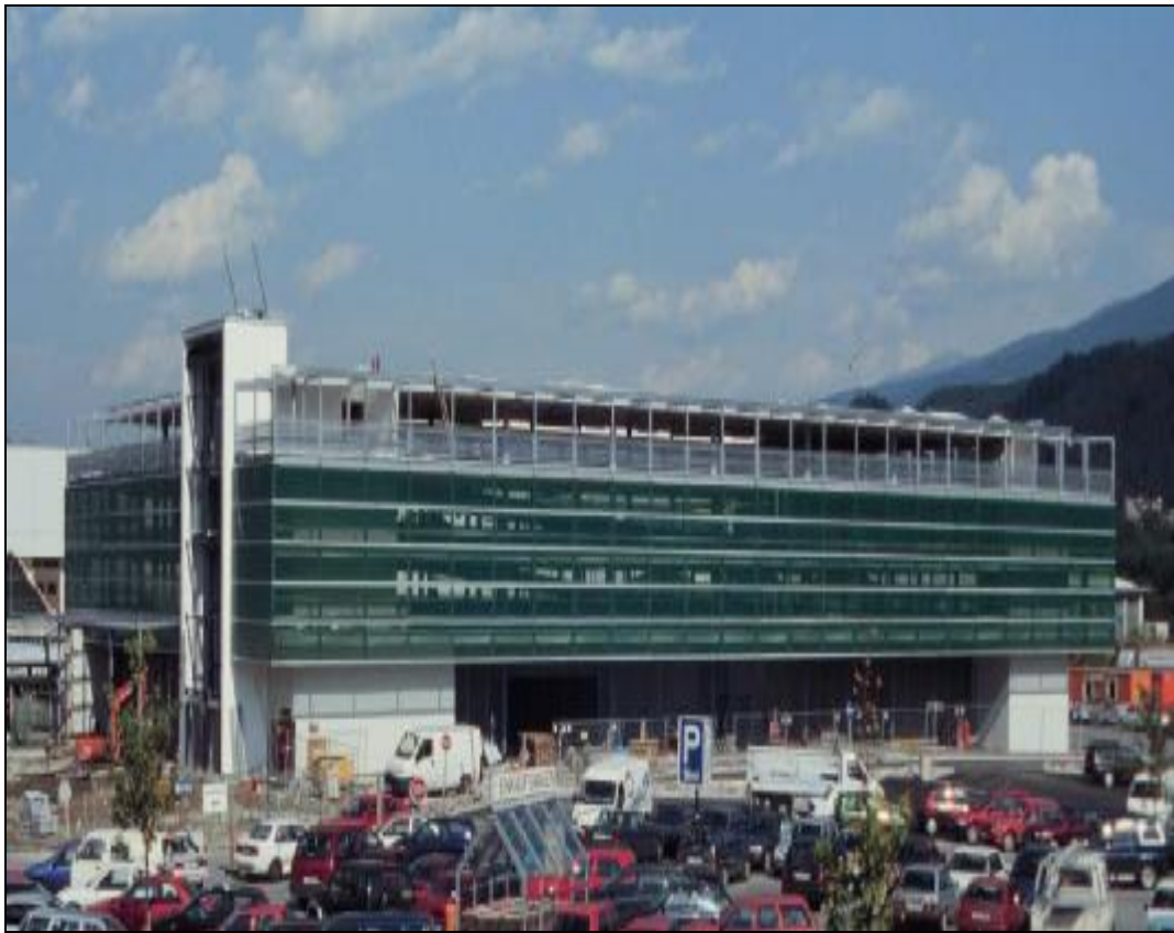
Photo 1-4: vue générale du parking « DEZ » [15].
