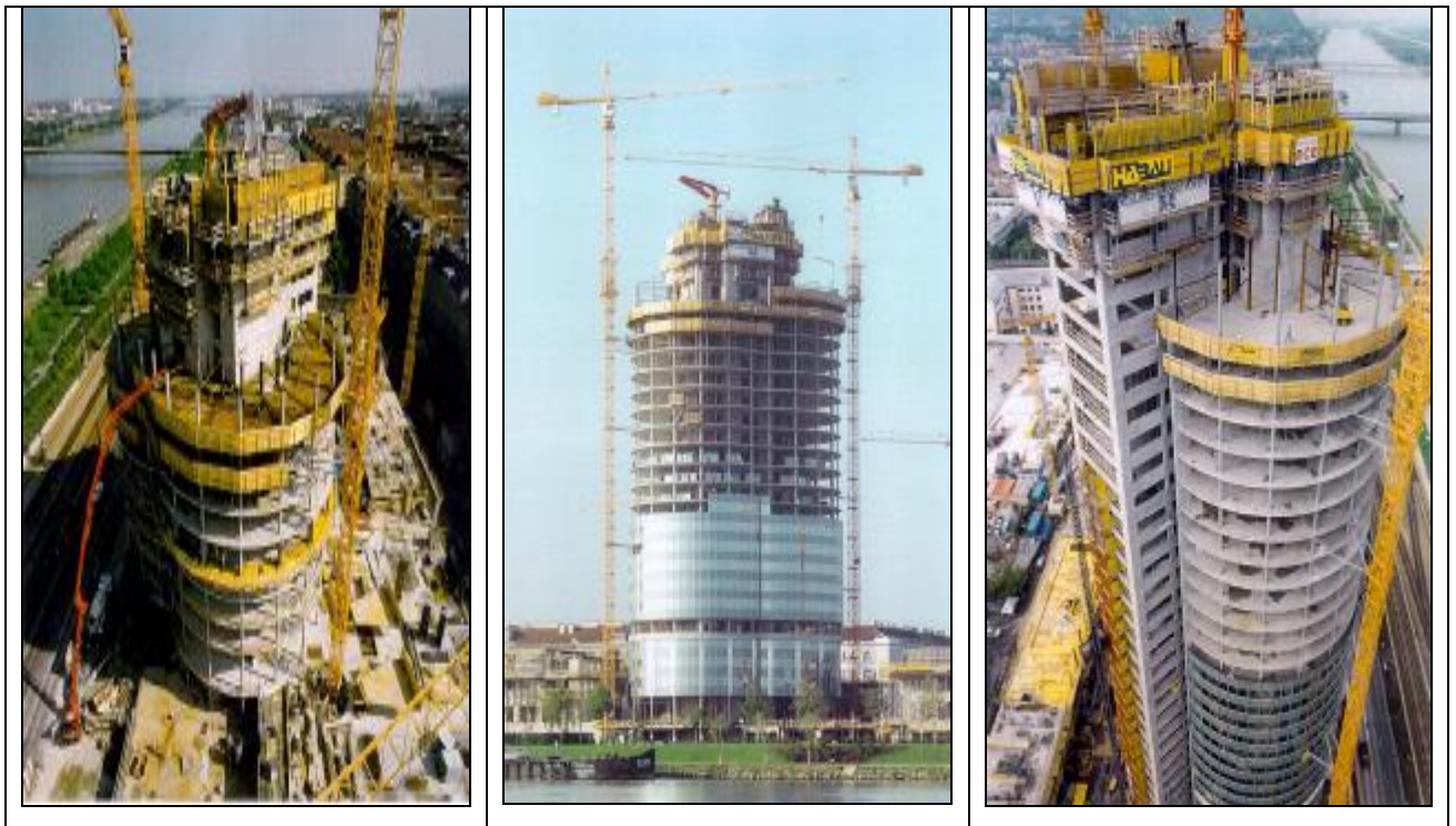
Photo 1-1: Etapes de la construction de Millennium Tower (temps total de construction = 8 mois)
