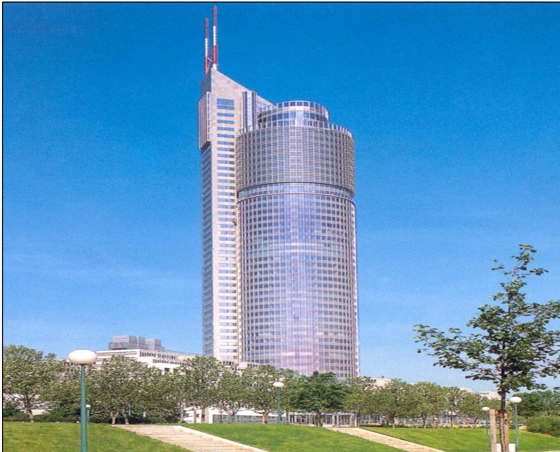
Photo 1-2: Millennium Tower Vienne (Autriche) [15].
