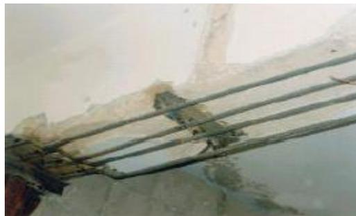
*Figure 3.1 : Renforcement d'une poutre par adjonction d'armatures additionnelles en sa partie inférieure.*
