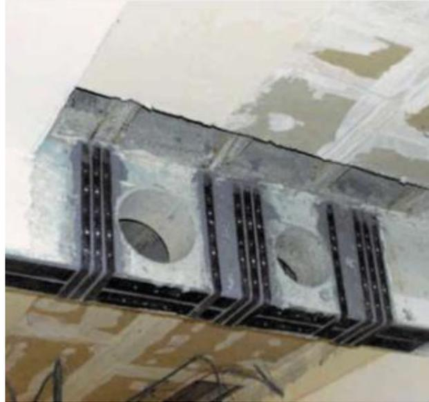
*Figure 3.8: renforcement d'une poutre au moyen de matériaux composites*
