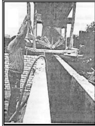
Fig.2.25 . Coulage d'une dalle de cave avec du béton à fibres Fortius
