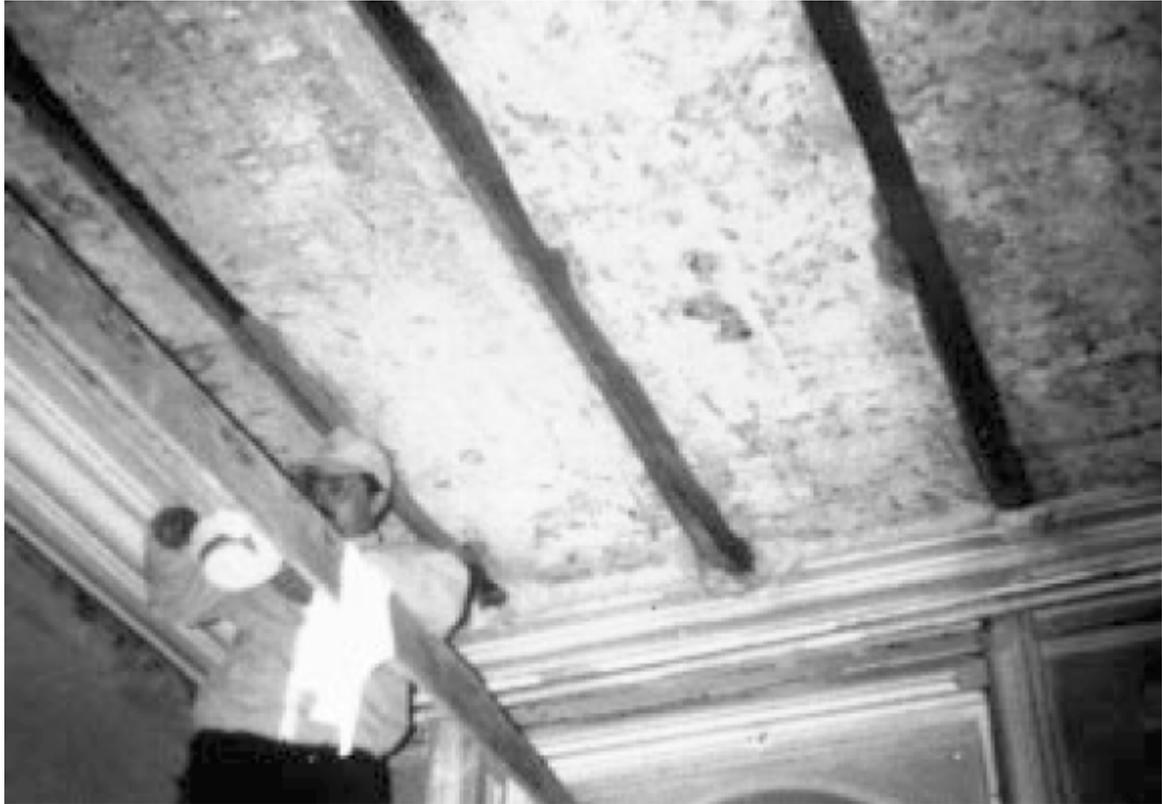
*Figure 3.9 mise en place de lamelles en PRF sur une dalle d'un ancien appartement*
