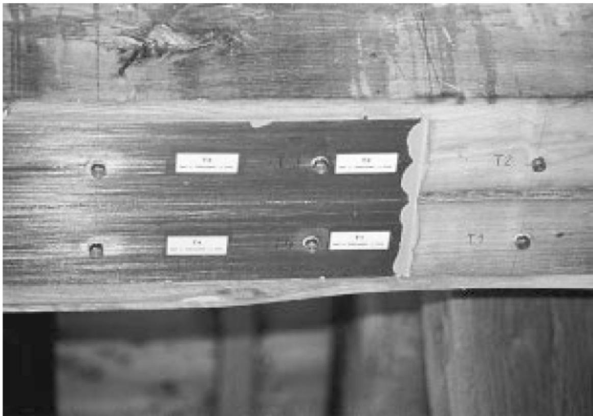
**Figure 3.7** fixation des lamelles sur des poutres en bois
