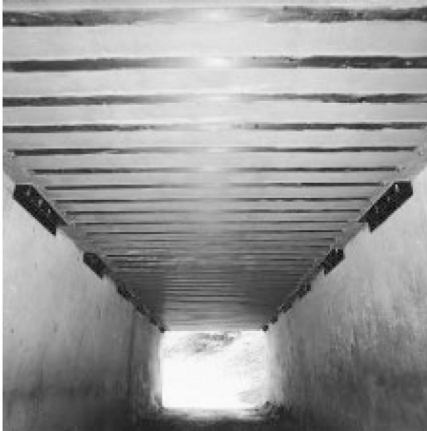
*Figure 3.8 renforcement d'un dalot par du PRF*
