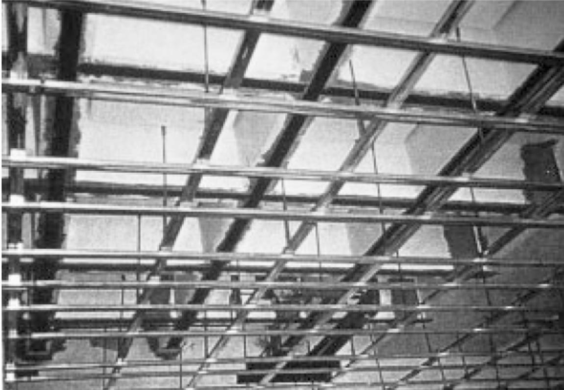
**Figure 3.11 Renforcement d'une dalle en gaufre par du PRF**
