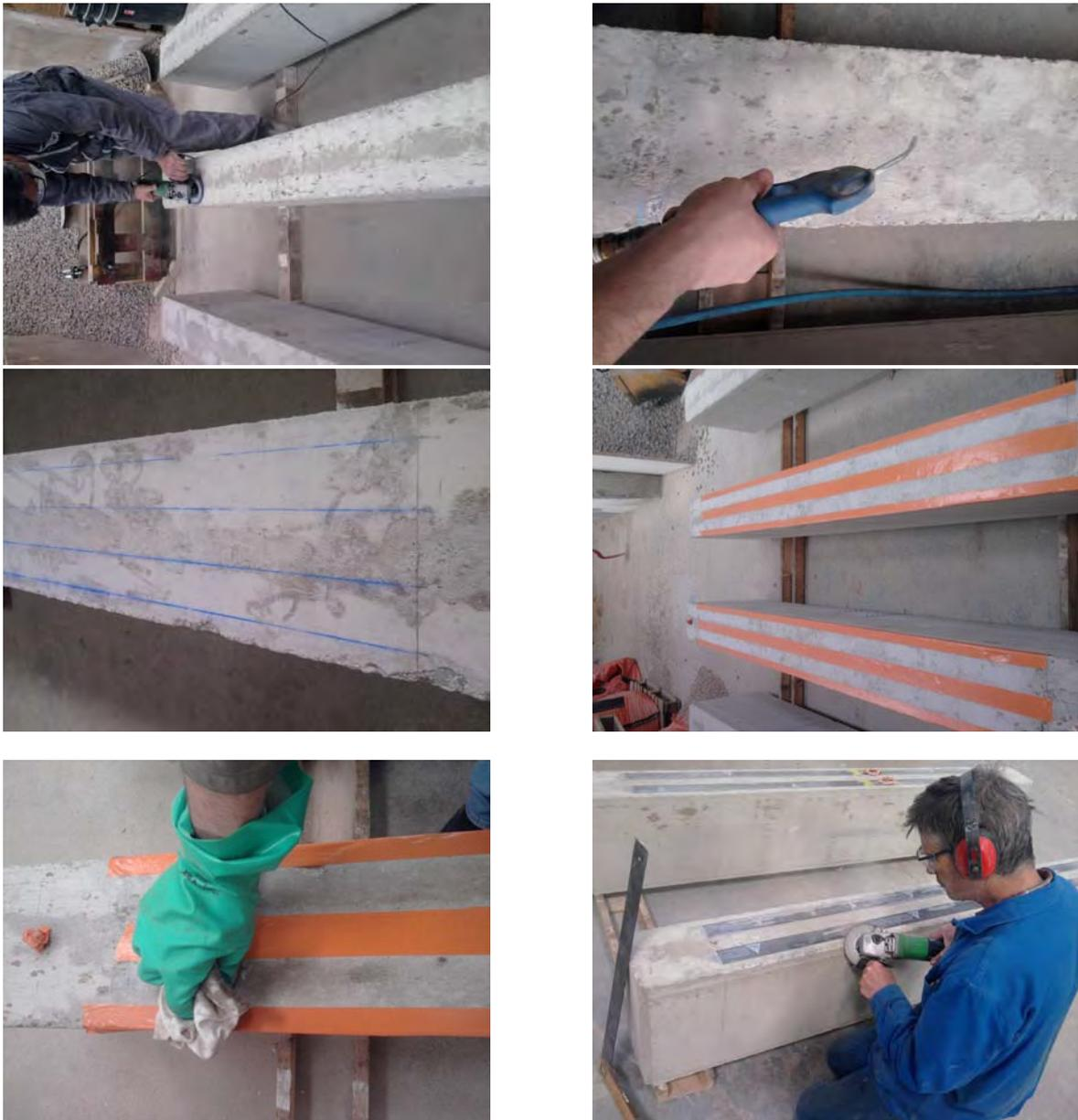
**Figure B.1.** Préparation de la surface du support (Ponçage, nettoyage, traçage, arrondir les angles droit)
