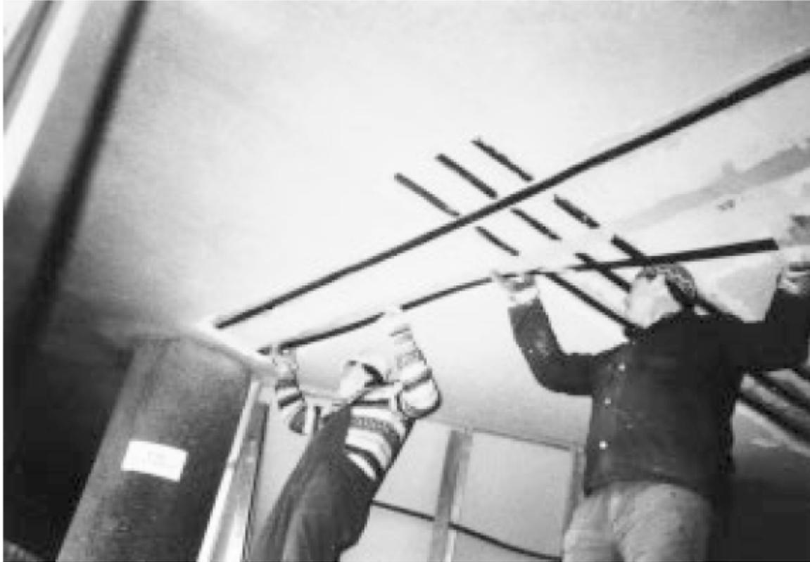
***Figure 3.10 mise en place des lamelles en PRF sur une dalle d'un hôpital***
