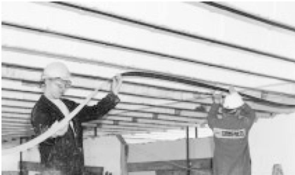
**Figure3.5 mise en place des lamelles en PRFC sur une dalle en béton armé**
