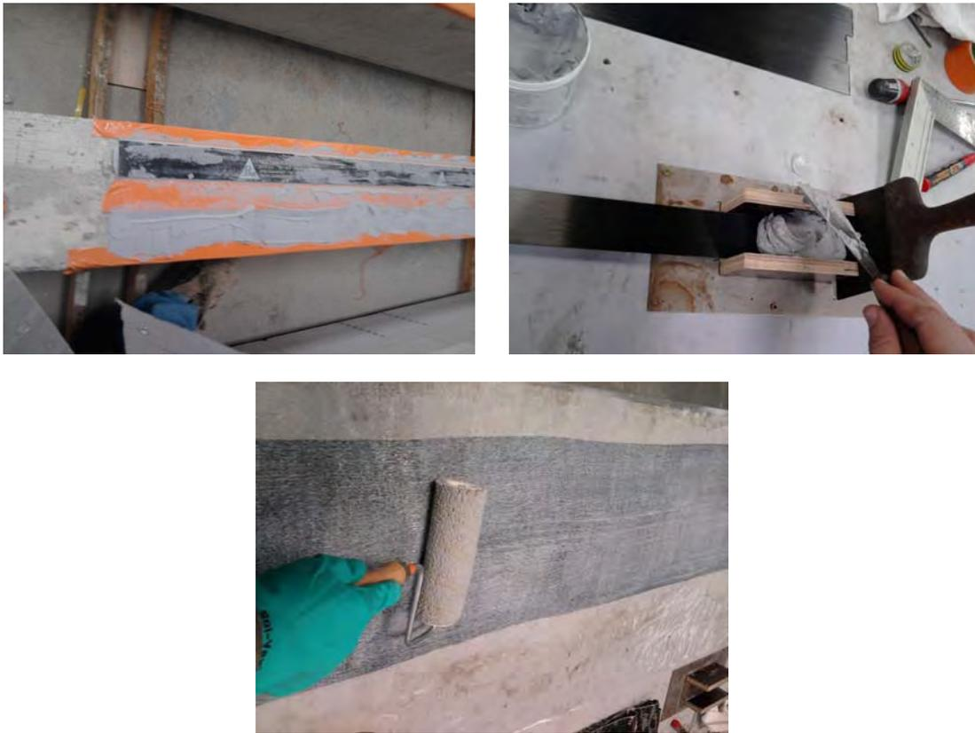
Figure B.4 Mise en place de la résine
