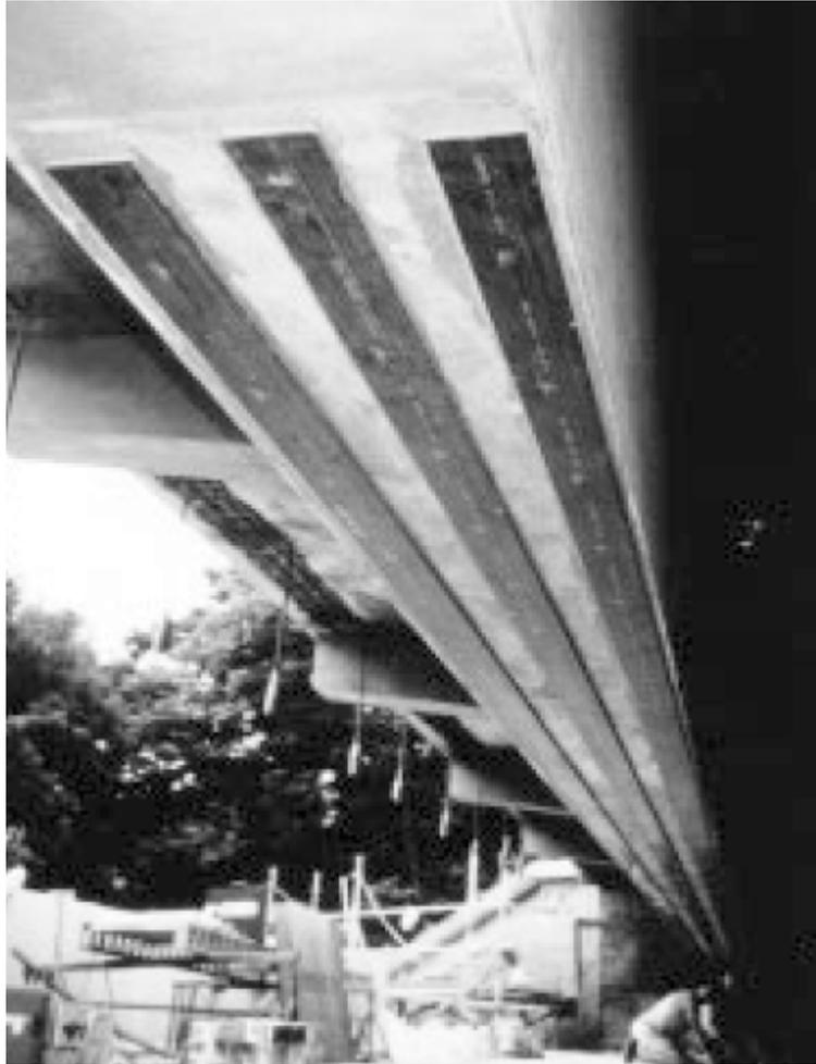
**Figure 3.12 Renforcement d'une poutre d'un pont par du PRF**
