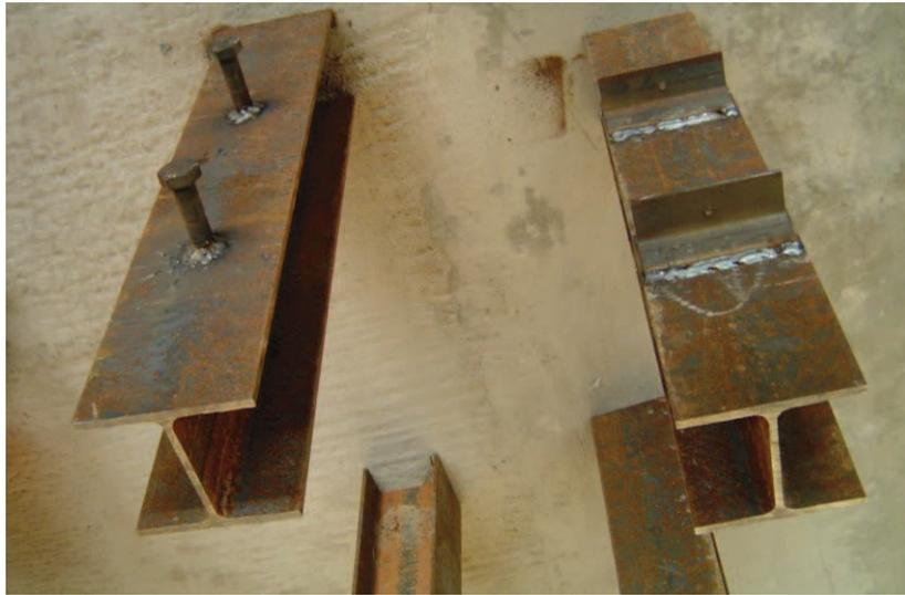
Photo 4.4 : Profilé métallique avant coulage des dalles.
