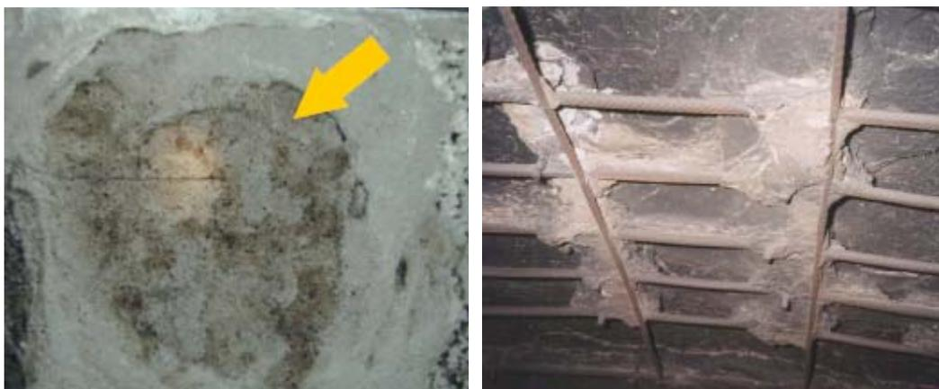
Figure 2.27 ; Ecaillage lors de l'incendie du tunnel mont blanc
