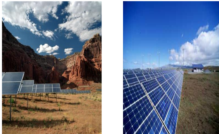
Figure.1.3 Parc de panneaux photovoltaïques [16]
