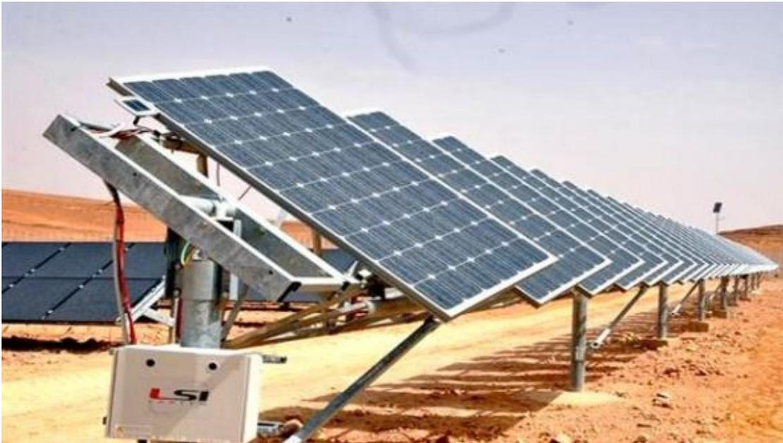
*Figure 2. 2 Mini-centrale solaire de puissance 1.1 MW (6.000 panneaux photovoltaïques) ville de Ghardaïa*
