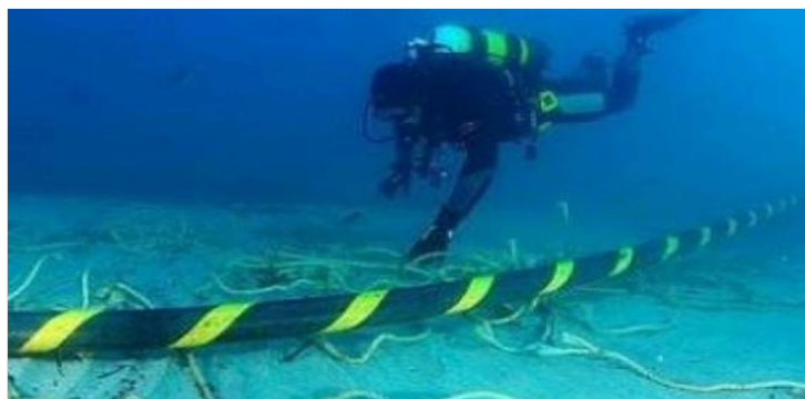
Figure 1.13 : Travaux de réparation sur un câble sous-marin
