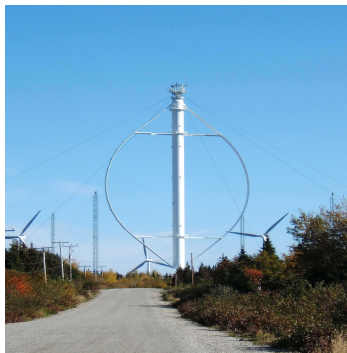
Figure V.2 : Configurations des Eoliennes à axe vertical
