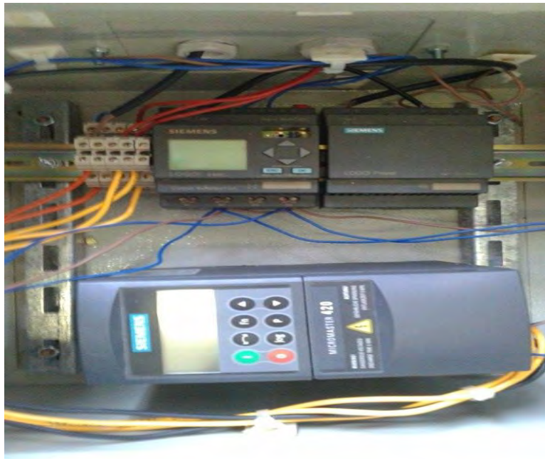
Figure 3.4 : Photographie de la partie commande du spin coater.
